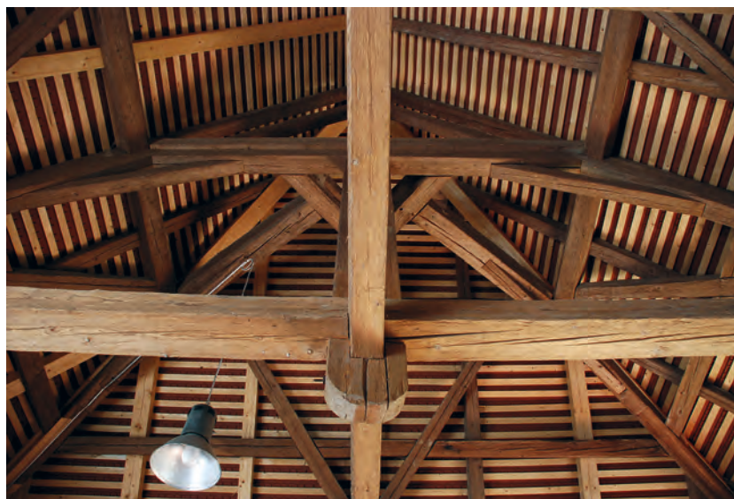
Blick in das gewaltige Dach des einstigen Torkeles in Salem-Mittelstenweiler.
