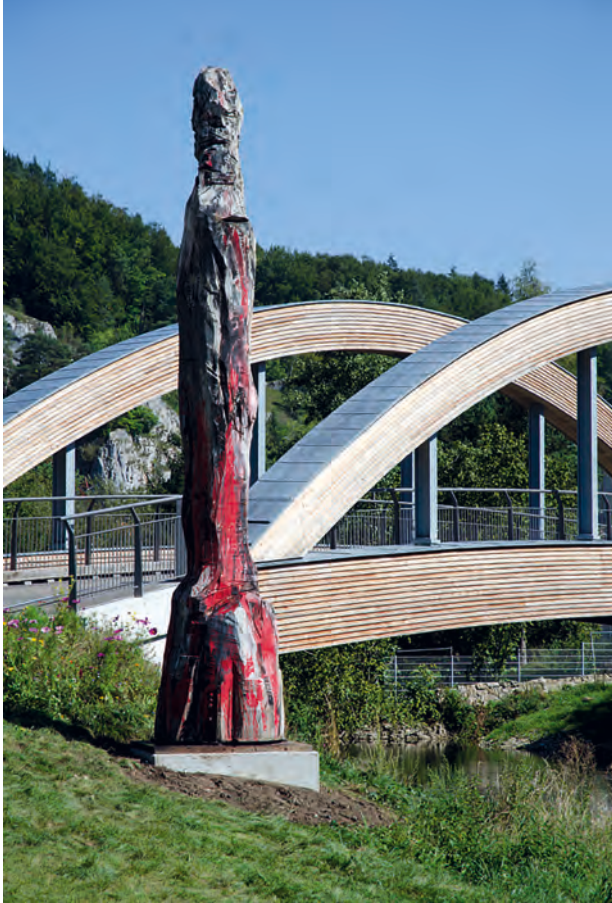
Klaus Prior: Ibykus I , 2010, neue Donaubrücke bei Gutenstein.
