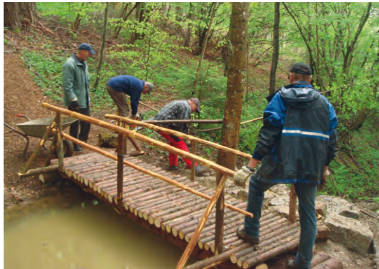
Als künftiger Wanderweg braucht der historische Wirtschaftsweg nun eine Brücke.
