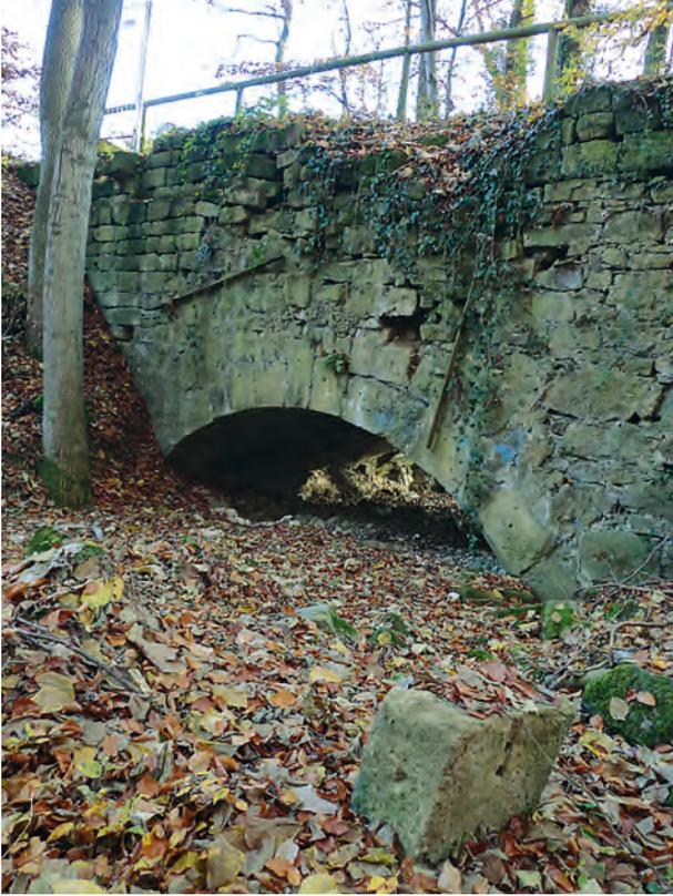
*Die nördliche Wange mit dem noch gut erhaltenen Brückenbogen und der ungewöhnlich hoch aufragenden Brückenwange; im Vordergrund ein Deckstein der zahlreichen abgestürzten behauenen Steine aus der Brückenbrüstung mit den originalen Löchern für die Stahlklammern.*
