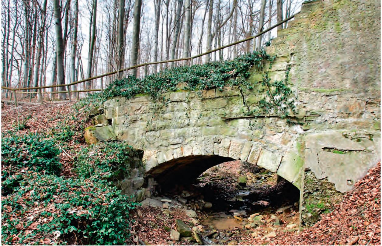
Die südliche, talseitige Wange der Teufelsbrücke ist stark vom Verfall gezeichnet. Das linksseitig anschließende Stützmauerwerk des Straßendamms ist auf einer Länge von 15 Metern vollständig abgegangen, ein Rest von ca. zwölf Metern noch erhalten.
