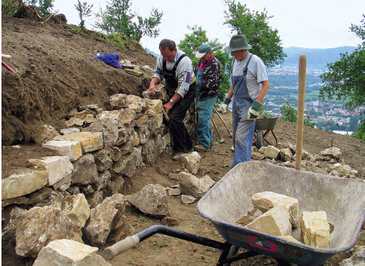
Die Restaurierung alter Weinbergmauern, wie hier am Georgenberg in Pfullingen, macht die Nutzungsgeschichte einer historischen Kulturlandschaft wieder ablesbar.
