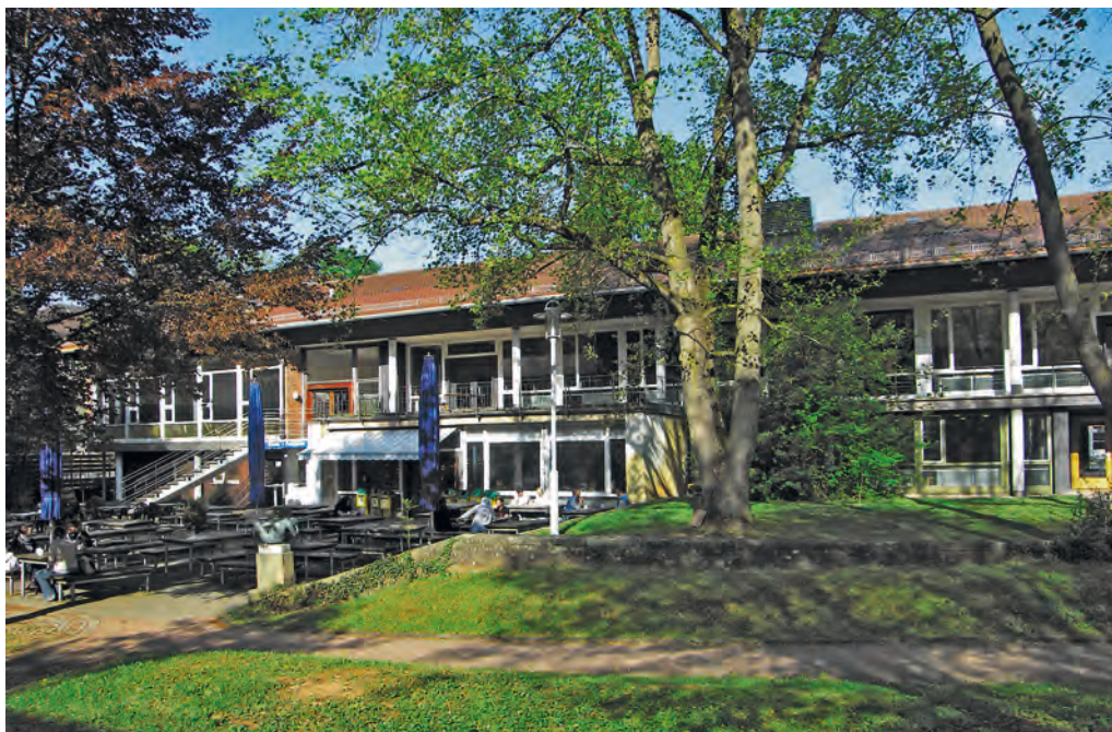
Rückfassade des Clubhauses an der Tübinger Wilhelmstraße, in den 1950er-Jahren erbaut von Rolf Gutbrod.
