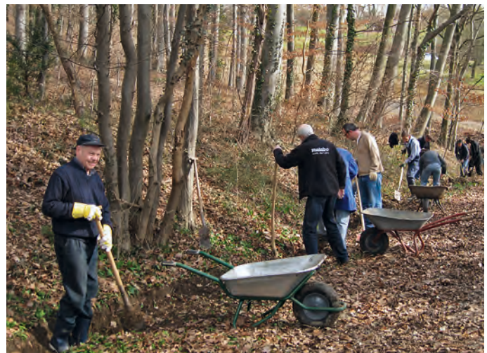
Erste Sicherungsmaßnahmen für das Denkmal Teufelsbrücke zwischen Oberensingen und Hardt.
