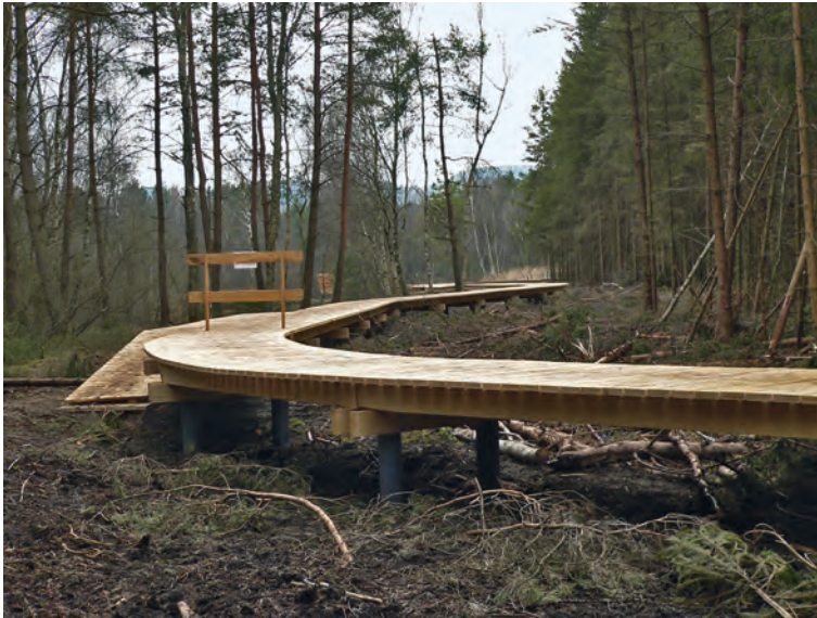
Ein Bohlensteg führt die Besucher trockenen Fußes durch den für Wiedervernässung vorgesehenen Bereich am Fünfeckweiher.
