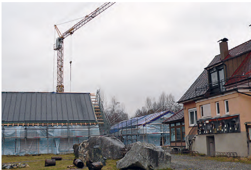
Fortschritte auf der Baustelle: rechts das alte Naturschutzzentrum, links das neue Ausstellungsgebäude mit Photovoltaikanlage, daneben das Vortrags- und Seminargebäude.
