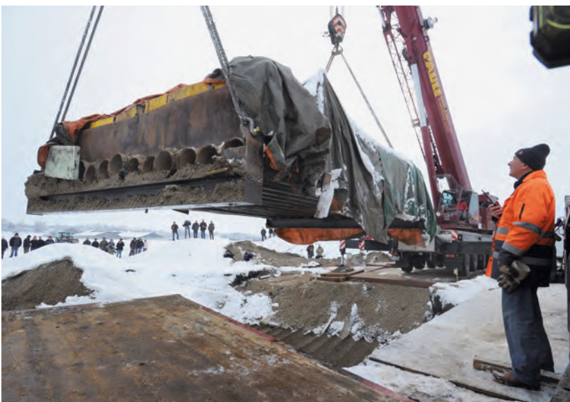
Achtzig Tonnen am Haken: Die Grabkammer wird auf einen Tieflader gehoben.
