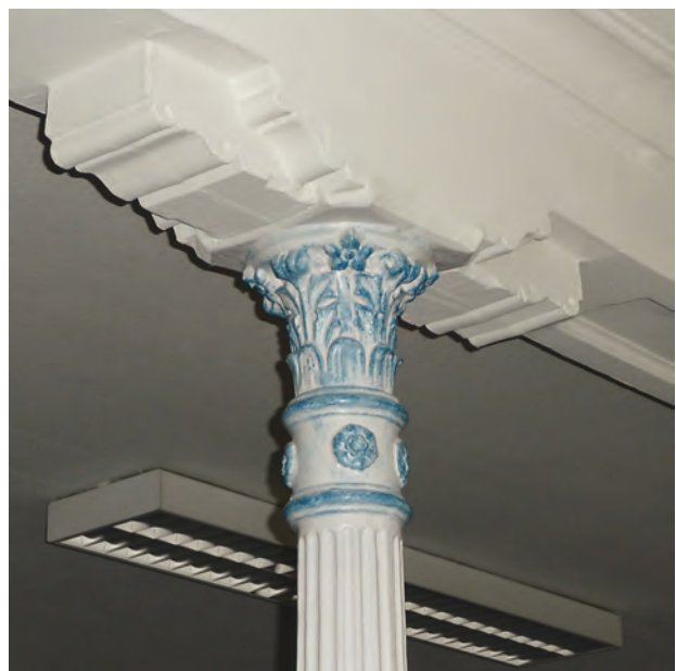
Ein hübsches Baudetail: gusseiserne Säule von 1884.
