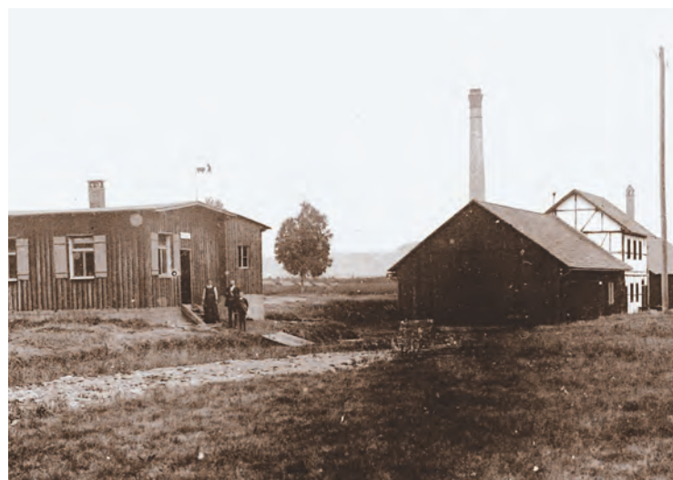
Kantine und neue Torfstreu-fabrik des «Zeiler» Werks, ver-mutlich 1914, mit Kantine-wirtin Antonie Mahler und Familie. Deutlich zu sehen ist das Torfwerk und der hohe Kamin für die Dampfmaschine.
