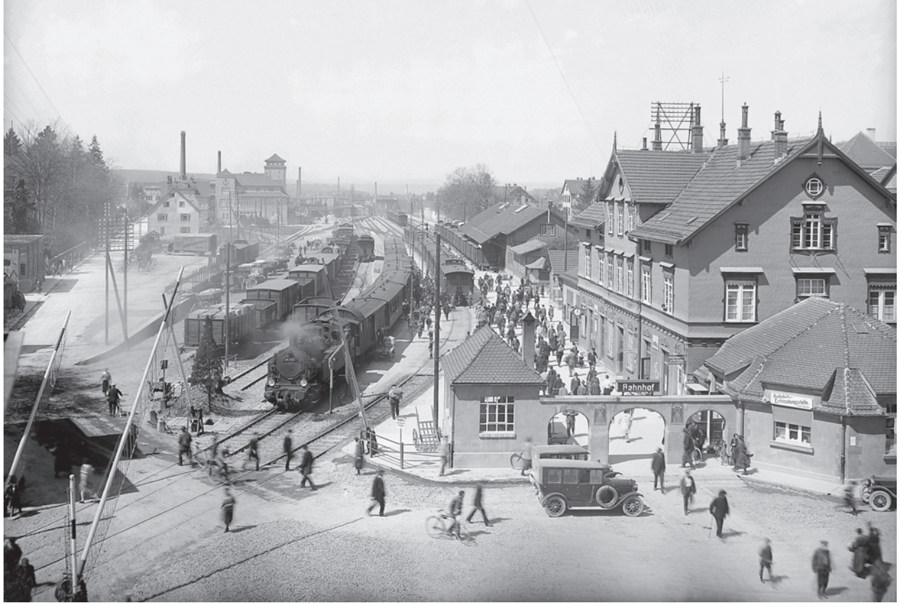
Bald wird diese Dampflok mit ihren Waggons, die noch im Kirchheimer Bahnhof wartet, losfahren. Aufnahme von 1927.
