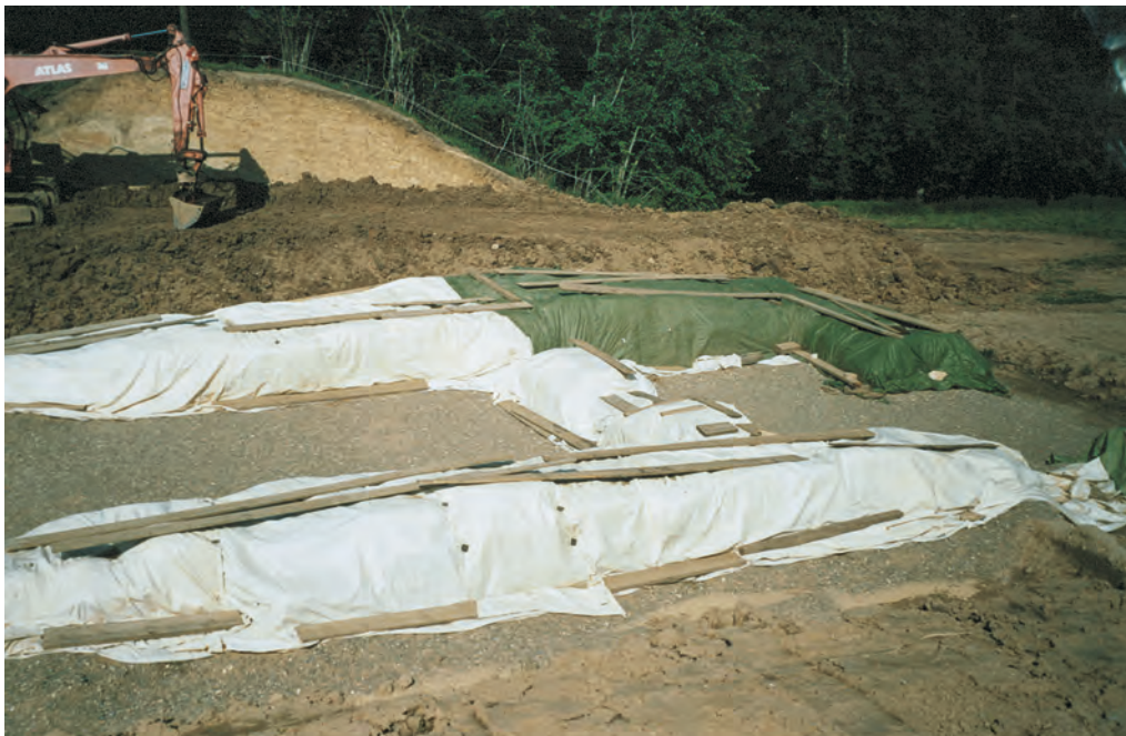
Wetterfest verpackt ist das 2.600 Jahre alte Steintor aus keltischer Zeit. Der hallstattzeitliche Wall oben hinter dem Bagger soll wieder bis zum Tor aufgeschüttet werden. Die nicht sichtbare Heuneburg liegt weiter rechts.
