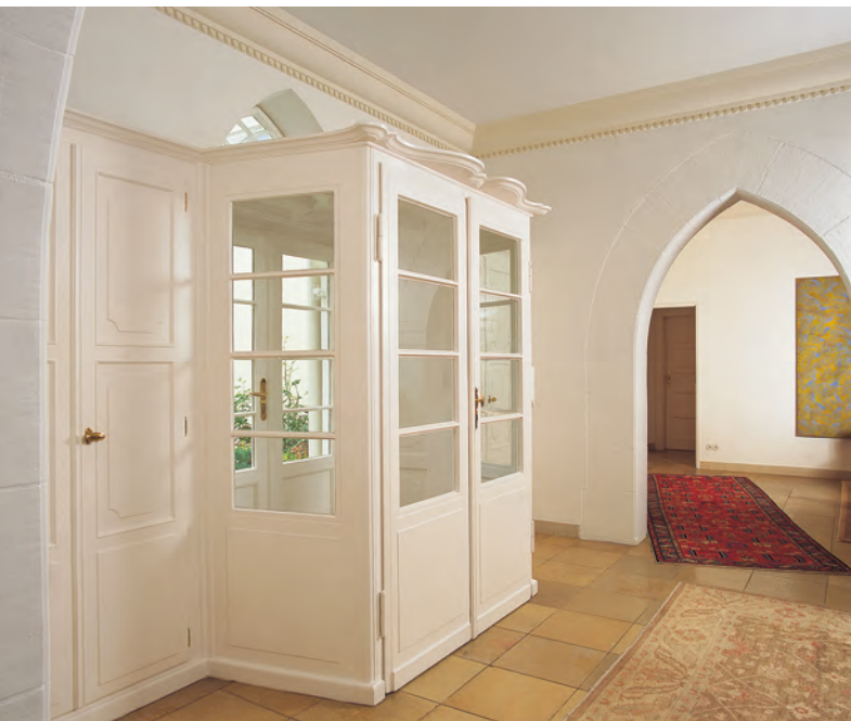
Vorbildliche handwerkliche Reparatur der Originalausstattung der Villa Kahn. Hier der Windfang in der Eingangshalle.
