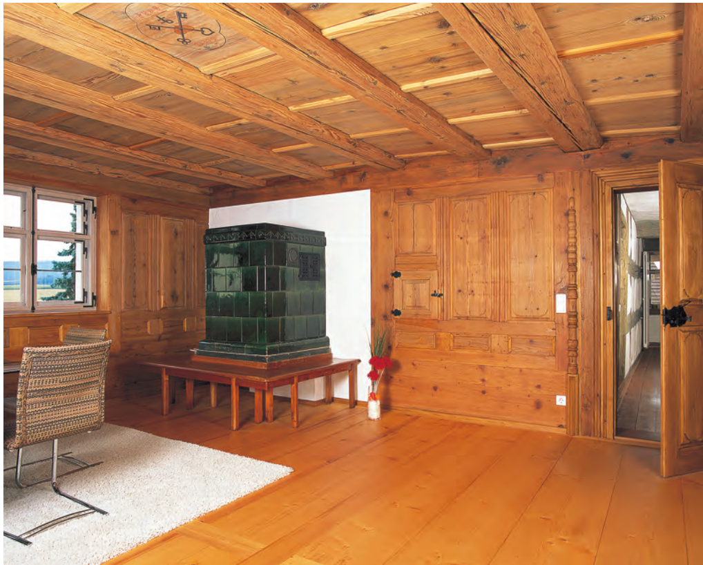
Die große Stube des «Götzhauses» mit reparierter bauzeitlicher Holztäferung und altem Kachelofen.
