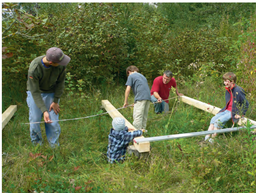
Der Lehrer Frieder Guggolz baut zusammen mit Schülern der Bienen-AG auf dem Gelände des SHB-Naturschutzzentrums das neue Bienenhaus.
