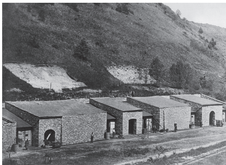
Gebäude aus der Zeit um 1870 in für die Pulverherstellung typischer Bauweise mit massiver Ummauerung und leichten Blechdächern, die im Falle einer Explosion den Schaden begrenzen sollten.
