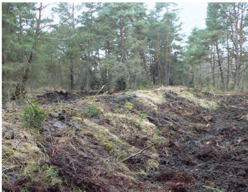
Rückvernässung im Hochmoor – Fertiggestelltes Torfwehr im Großen Trauben.
