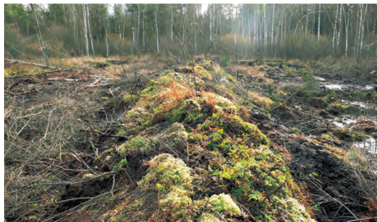
Oben: Die Abdeckung mit Vegetationssoden verhindert die Erosion der Dämme.
