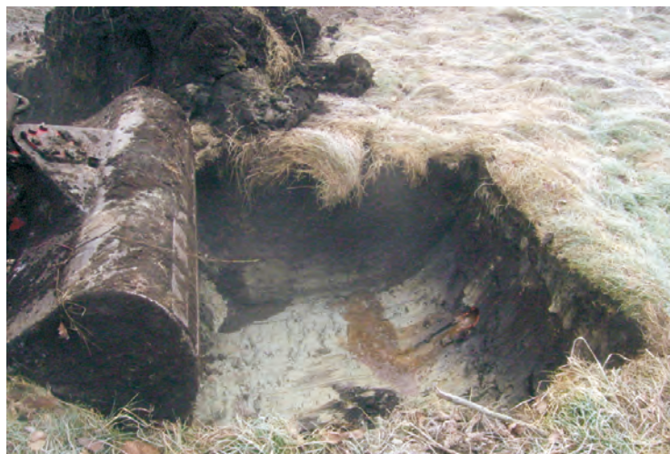
Unten: Die Unterbrechung von Dränagen auf nicht mehr genutztem Grünland unterbindet wirksam die künstliche Entwässerung.
