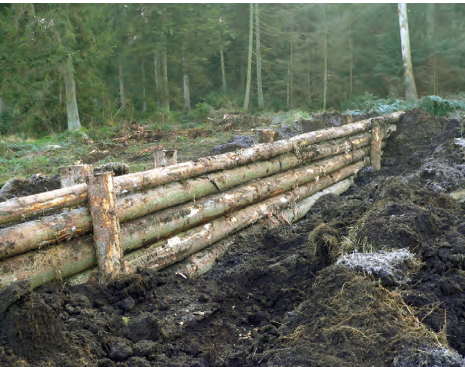
Entastete Fichtenstämme werden zu Hindernissen verbaut, um das Abfließen des Regenwassers aus dem Moorkörper zu hemmen oder zu verhindern.
