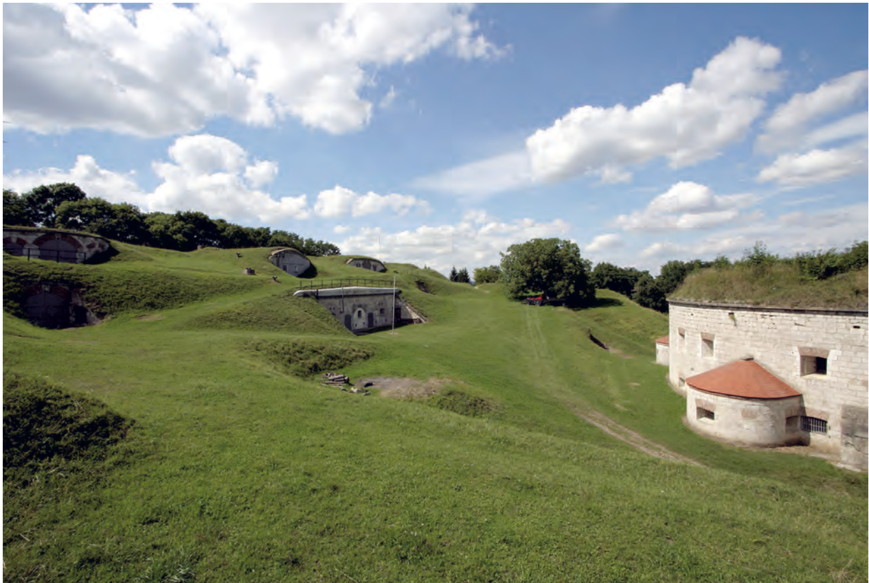
Blick in den Werkshof. In dem Grün sind die gemauerten Eingänge zu erkennen. Links das Innere des Hauptwalls, rechts das halbmondförmige Reduit.
