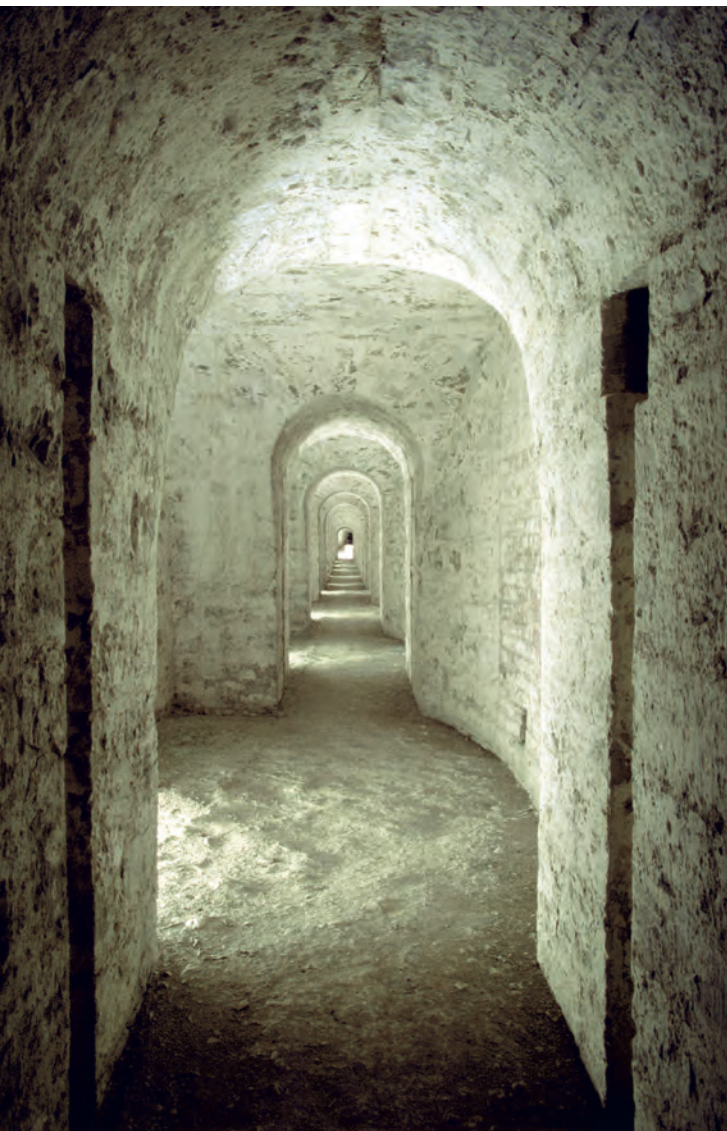
In den Kasematten des Forts Oberer Kuhberg, die Decharge-Galerie an der Frontseite.
