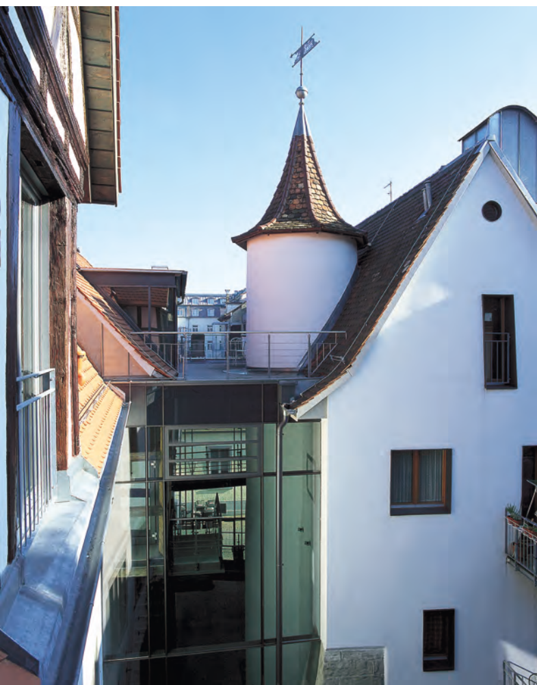
Nach der Freilegung der Häusergruppe Sigismundstraße in der Konstanzer Altstadt bildet eine gläserne Halle die notwendige Zäsur zwischen den historischen Bauten.
