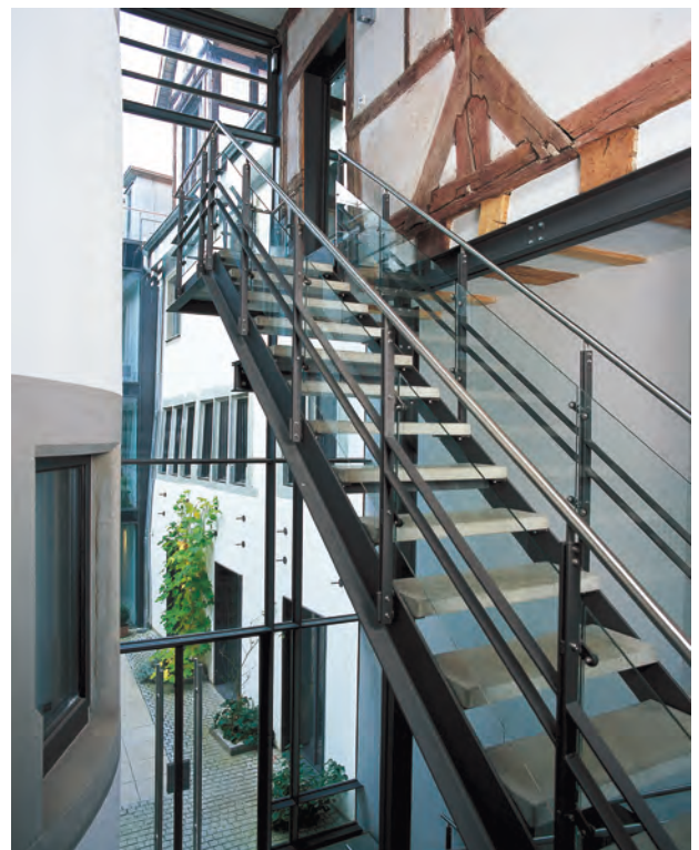
Ein moderner Treppenlauf im bewussten Kontrast zu den restaurierten Bauteilen aus Mittelalter und Renaissance.
