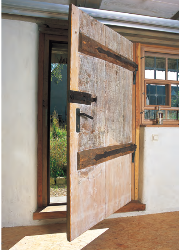
Von hervorragender handwerklicher Qualität sind die Reparaturen und der Nachbau des Holzwerks in Hausen ob Verena.
