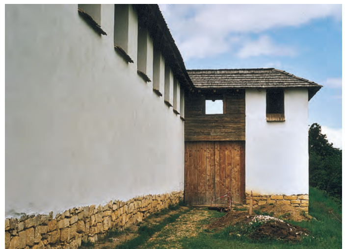
Rekonstruktion der berühmten Lehmziegelmauer auf der Heuneburg bei Herbertingen-Hundersingen. Die dicke Kalkschicht schützt die luftgetrockneten Lehmziegel dauerhaft.
