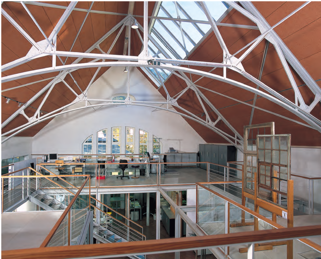
Der ehemalige Speisesaal der Arbeiterkantine mit eiserner Dachkonstruktion von 1909. Die neuen Einbauten für Büros und Ausstellung bestechen durch ihre Leichtigkeit.
