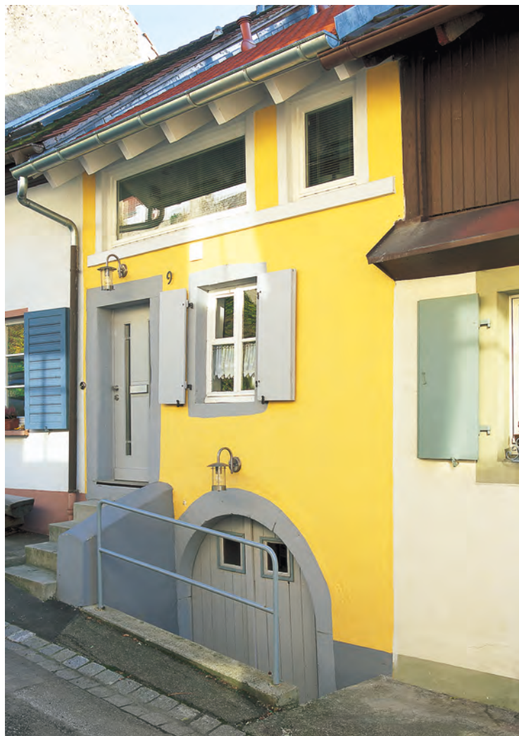
Dieses Tagelöhnerhäuschen, das nur 3,80 Meter breit ist, steht in Burkheim im Kaiserstuhl. Durch die Verglasung des Kniestocks oben fällt das Licht in das neue Bad.
