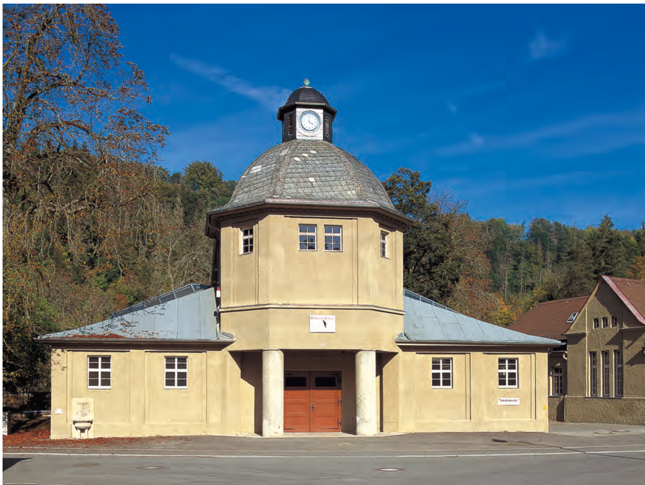
Auch wenn Aussehen und Name anderes vermuten lassen – die «Jakobskirche» diente als Wasch-, Umkleide- und Schlafsaalgebäude für die Arbeiter der Pulverfabrik Rottweil ganz profanen Zwecken. Vorbildlich saniert, ist hier heute die Schreinerei der Holzmanufaktur Rottweil untergebracht.
