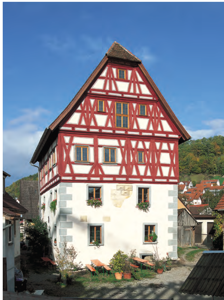
Das imposante «Senftenschlössle» in Untermünkheim nach der Sanierung. Im ehemaligen Adelsitz kann man heute übernachten.
