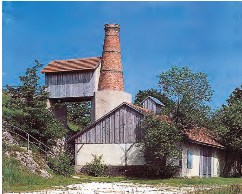
Das Kalkofenmuseum des Schwäbischen Heimatbunds in Untermarchtal. Oben wurde im Steinbruch das nötige Material gewonnen, Brennofen und Kamin bilden eine Einheit. Hinter dem Gebäude verläuft die Bundesstraße Ulm–Ehingen–Riedlingen–Sigmaringen.
