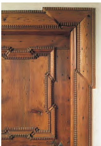
Detail von einer Tür des zweiten Obergeschosses mit wellenförmig profilierten sogenannten Rumpelleisten an Rahmung und Türblatt nach der Restaurierung.
