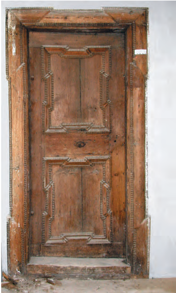
Türöffnung des zweiten Obergeschosses mit aufgedoppelter Kassettierung und Profilleisten an Türblatt und Rahmung während der Restaurierung.
