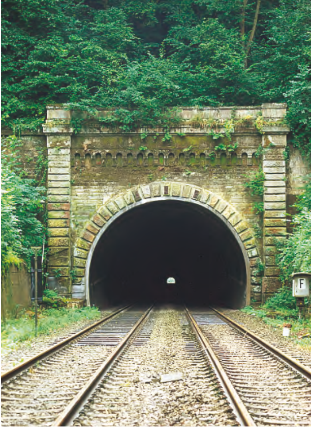
Der Weinsberger Tunnel vor dem Umbau, von Weinsberg her gesehen. Dieser Durchstich war lange umkämpft.
