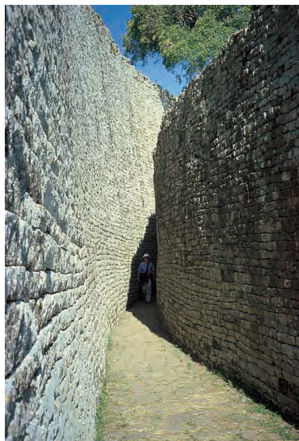
Blick auf die große Einfriedung mit ihrer gut erhaltenen Außenmauer.
