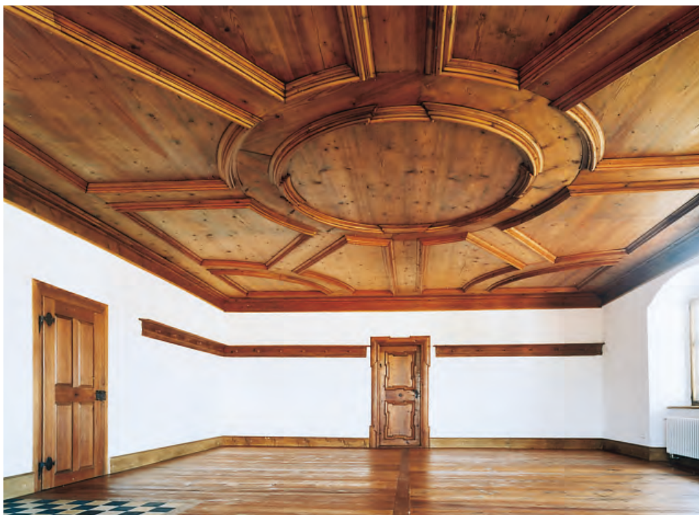
Gesamtansicht des Saals mit Holzdecke und Garderobe nach der Restaurierung. In der Mitte die Tür zur anschließenden Kammer.
