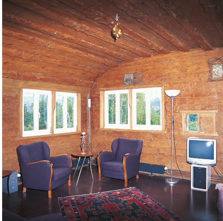
Die freigelegte und ergänzte Bohlenstube in ihrer originalen Holzichtigkeit. Die Fenster sind Einbauten des 20. Jahrhunderts.
