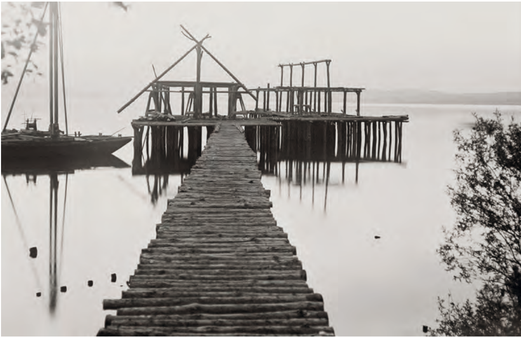
Aufbau der ersten beiden Pfahlbauhäuser im Mai 1922
