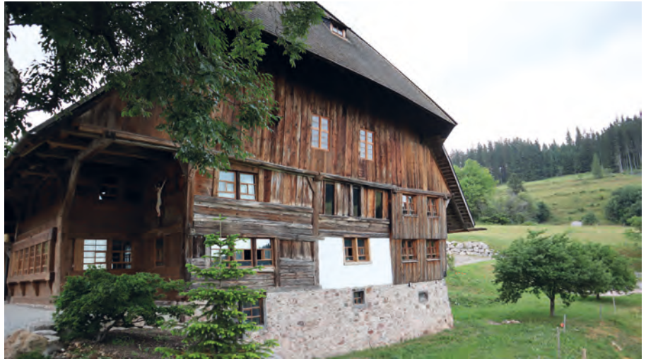
Der 1728 erbaute Wildenhof in Lenzkirch musste nach dramatischen Verformungen durch Wind und Hanglage aufwändig saniert werden. Die Bauherren Martin Wider sowie Maria und Jürgen Grieshaber erhalten dafür den Denkmalschutzpreis 2022/2023.
