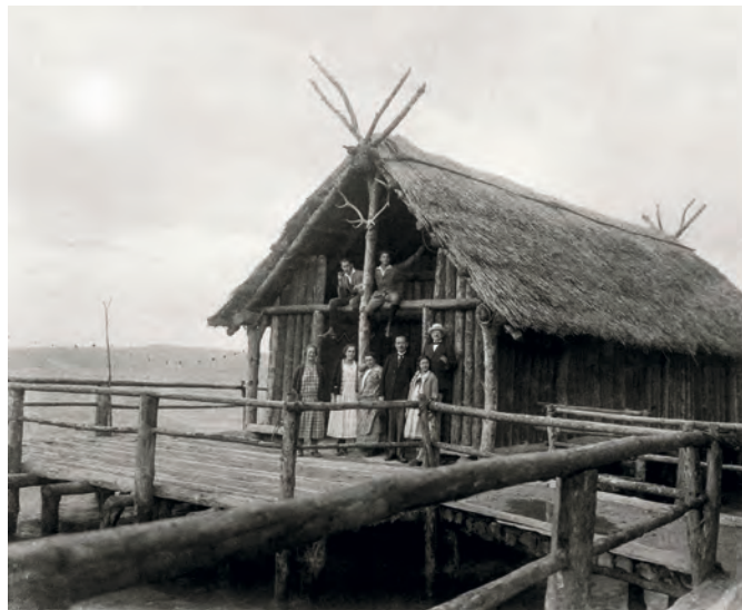
Die ersten beiden Pfahlbauten sind nach Vorbild der Ausgrabungen von Schussenried-Riedschachen (Federseemoor) entstanden.
