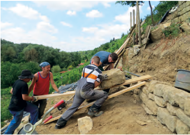
Beim Mauerbau werden möglichst viele helfende Hände gebraucht.
