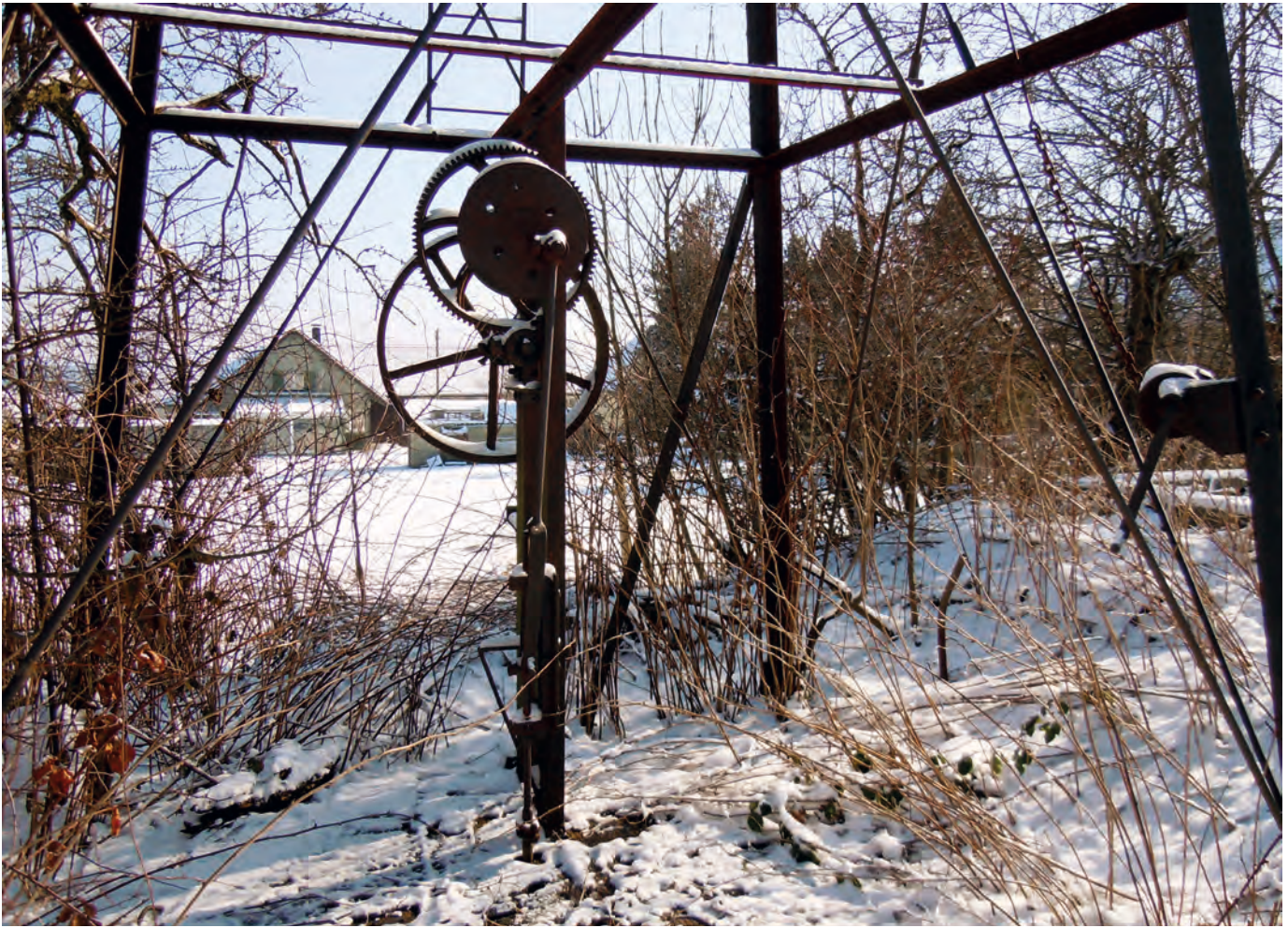
Aufbauten zur Regulierung der Wasserhebung am Windrad von Leutkirch-Ottmannshofen
