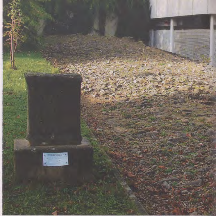
Konservierter Abschnitt der Straße bei der römischen Zivilsiedlung des Kastells von Benningen, Kreis Ludwigsburg. Die leicht gewölbte Straße verband wohl die römischen Kastelle Cannstatt und Walheim.
