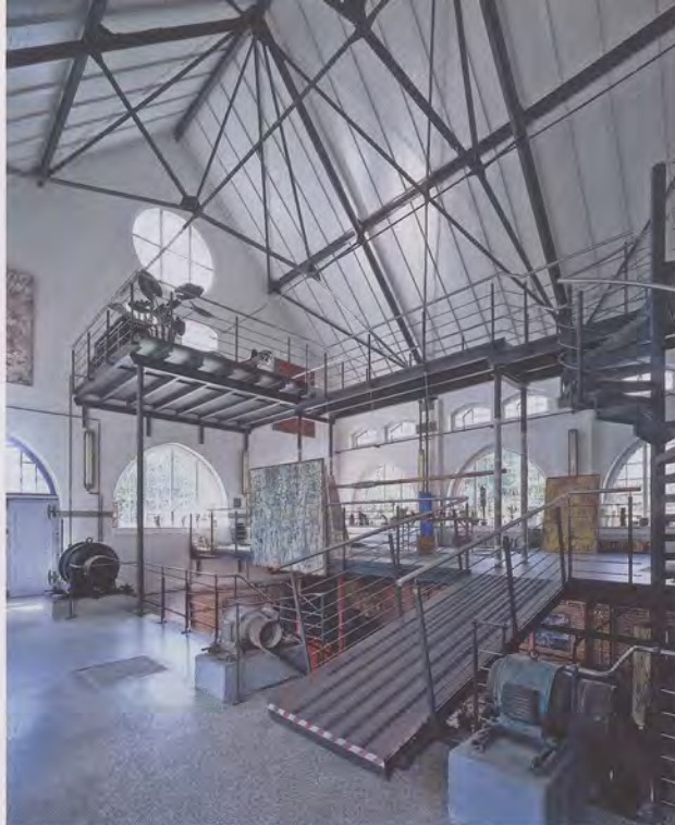
In beispielhafter Weise fügen sich die neuen Wohn-Einbauten in die vorgegebene Raumstruktur mit dem historischen Maschinenbestand ein.
