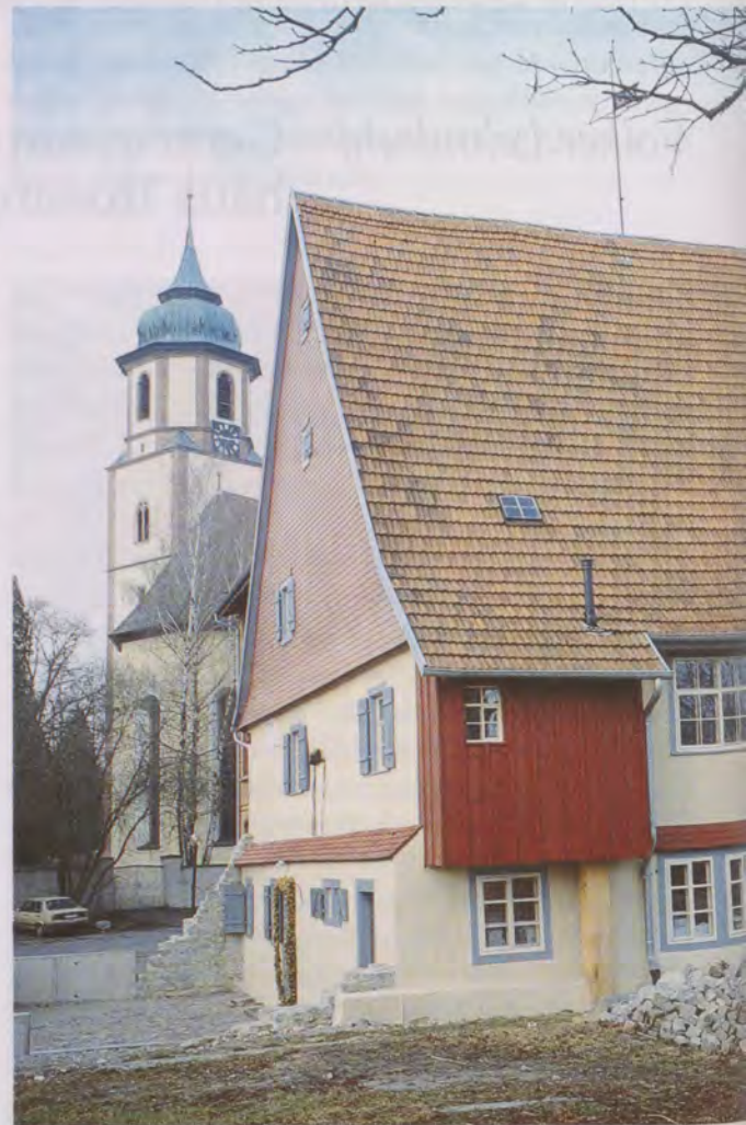
Die Nordfassade mit dem wieder hergestellten Aborterker und die neu mit Schindeln verkleidete Ostfassade. Mit der Martin-Luther-Kirche von 1742 und den angebauten Fabrikgebäuden der Harmonikafabrik bildete das Rat- und Schulhaus den weltlichen und geistlichen Mittelpunkt von Alt-Trossingen.
