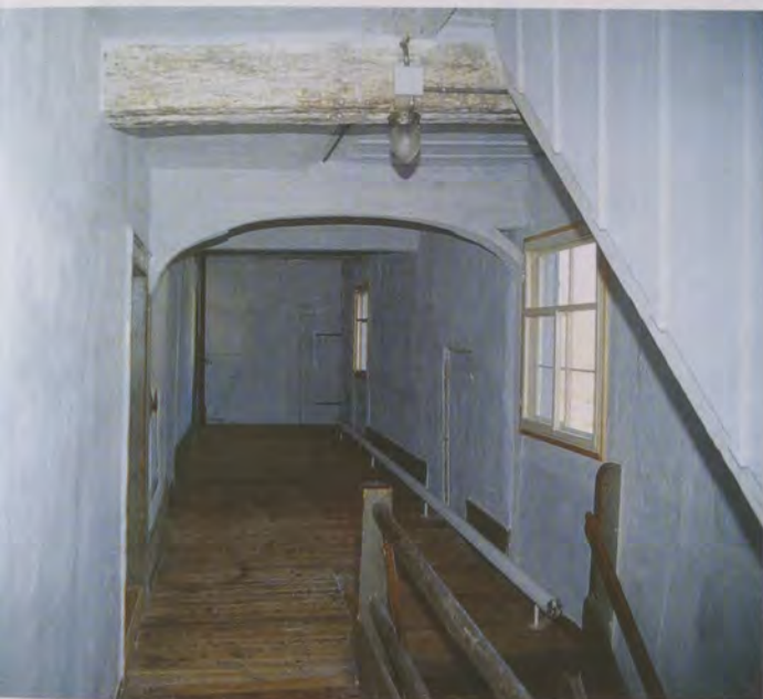
Oben: Flur im ersten Geschoss mit restaurierter Farbgebung.
