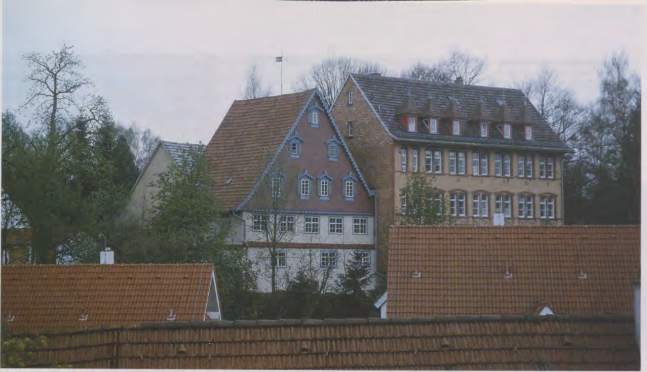
Das Alte Rat- und Schulhaus von Süden aus gesehen. Das ehemalige Kontorgebäude der Württembergischen Harmonikafabrik Chr. Weiss im Backsteinstil der Gründerzeit dient heute als «Lebenshaus» der ökumenischen Gemeinschaft für soziale Integration.
