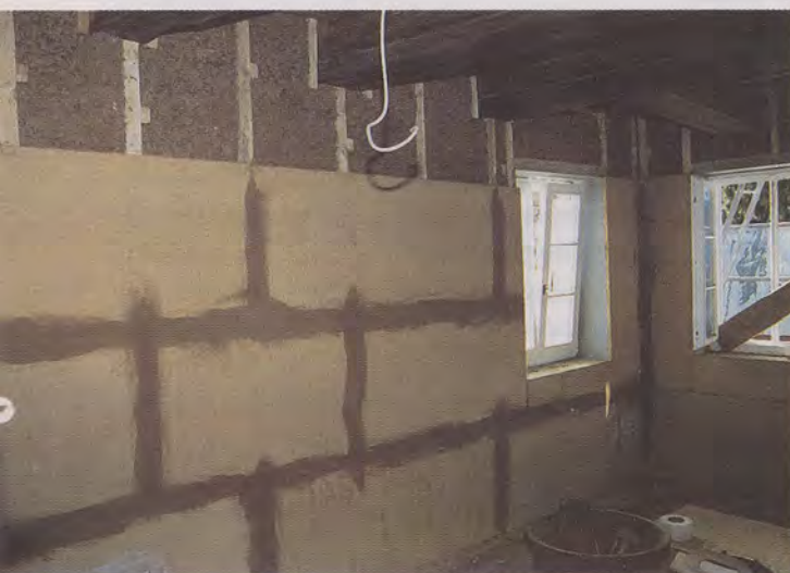
Unten: Innenseite einer Außenwand mit bereits zum Teil montierten Lehmbauplatten.
