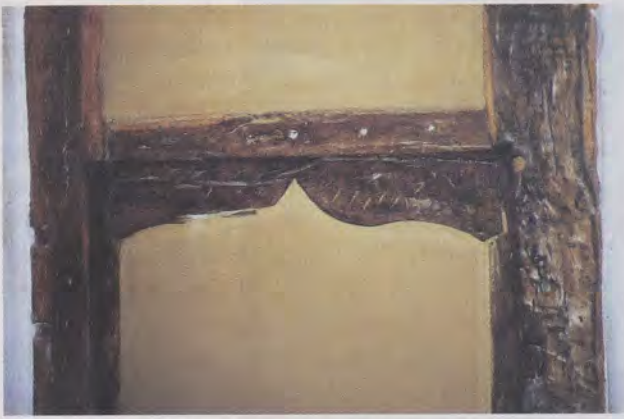
Auf den spätmittelalterlichen Kern des Hauses verweist im Erdgeschoss ein so genannter Eselsrücken in einer Wand.
