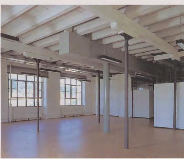
*Durch eine mittige neue Stahlkonstruktion, die aus brand-schutztechnischen Gründen verkleidet werden musste, konnte eine freie Einteilung der Geschosse in variable Büroräume erfolgen und die historische Deckenkonstruktion aus Holz mit den schlanken gusseisernen Stützen erhalten und in die neue Nutzung integriert werden.*
