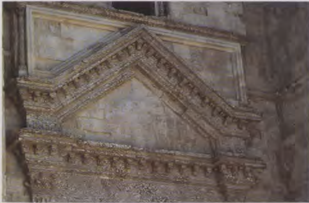
Das Giebeltympanon des Hauptportals von Castel del Monte wird von einem Konsolenfries gestützt. Die Anzahl der Konsolen lässt auf die Erbauungszeit schließen.
