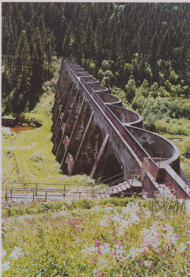
Im ehemaligen Staubecken vor der gewölbten Staumauer der Linachtalsperre wachsen schon Bäume.
