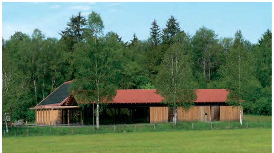
Die Gebäude des Naturschutzzentrums in Wilhelmsdorf nehmen bewusst die Architektur und die Tradition der Moorhütten im Pfrunger-Burgweiler Ried auf und schaffen die Klammer zur Vergangenheit des Moores.
