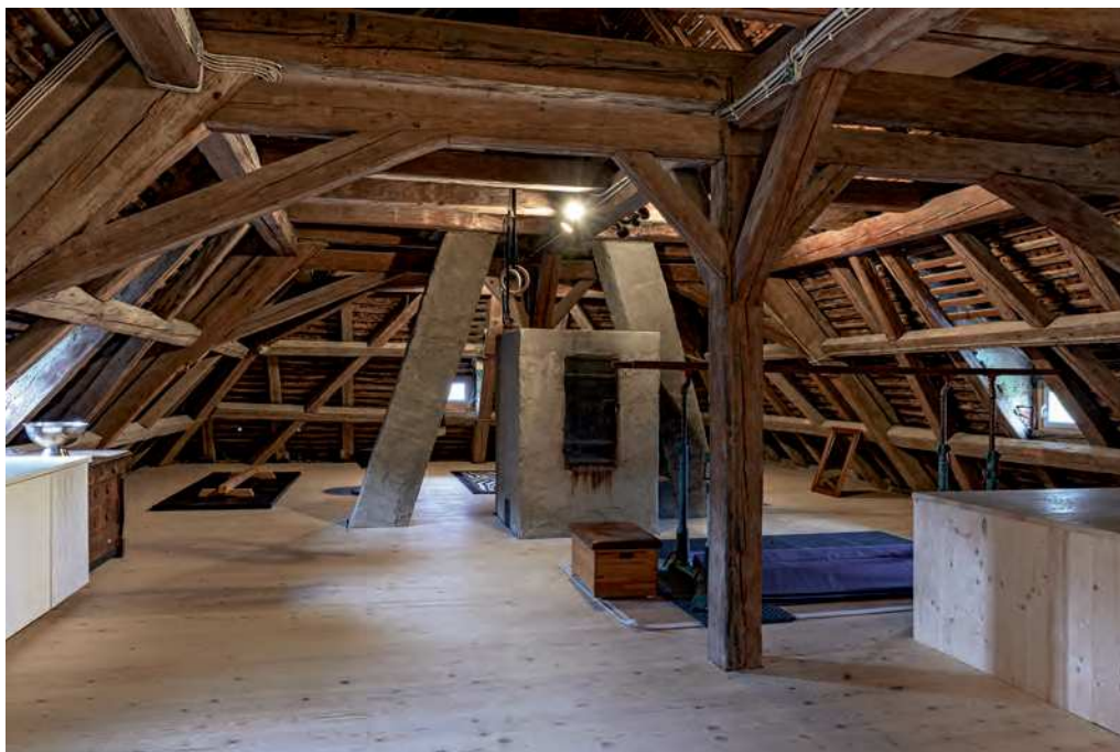
Der Dachstuhl als Fitnessraum: offengelassen und nur der Boden gedämmt. In der Mitte zwischen den verzogenen Kaminen eine alte Räucherkammer
