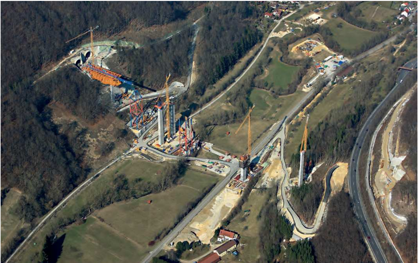
Bahntrasse Filstalbrücke im Bau, Aufnahme vom März 2018
