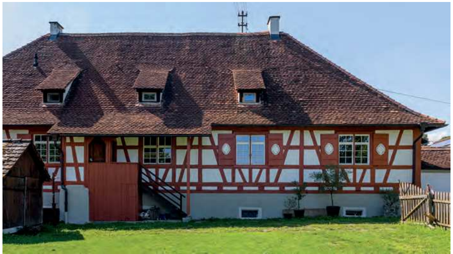
Einer der diesjährigen Preisträger ist das Jägerhaus in Bermatingen. Besonders markant ist das Zusammenspiel des Fachwerks, der Fensterläden und der Fenster, die nach dem letzten erhalten gebliebenen historischen Fenster des Hauses angefertigt wurden.
