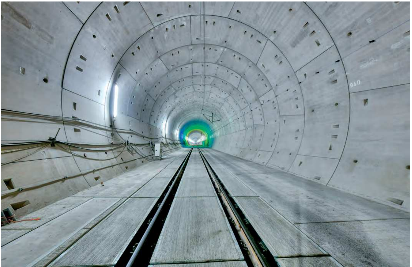
Blick in den Albvorlandtunnel Anfang Juli 2021, als die Gleisbauarbeiten weitgehend abgeschlossen waren. Dieser Tunnel mit einer Länge von 8.176 Metern unterfährt den Stadtteil Lindorf und die Anschlussstelle Kirchheim-Ost der BAB 8.
