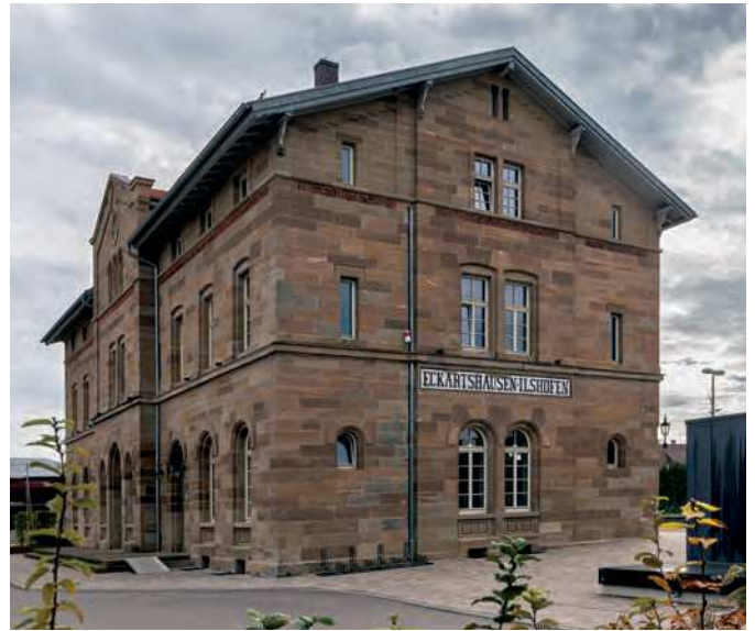
Ein repräsentativer Bau des 19. Jahrhunderts auf dem Land: der wiederbelebte Bahnhof Eckartshausen-Ilshofen, vorne das sich unterordnende neue Technikgebäude mit der Heizung
