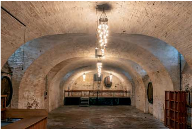
Überrascht durch seine Größe und Klarheit: der Gewölbehalle des Weinkellers
