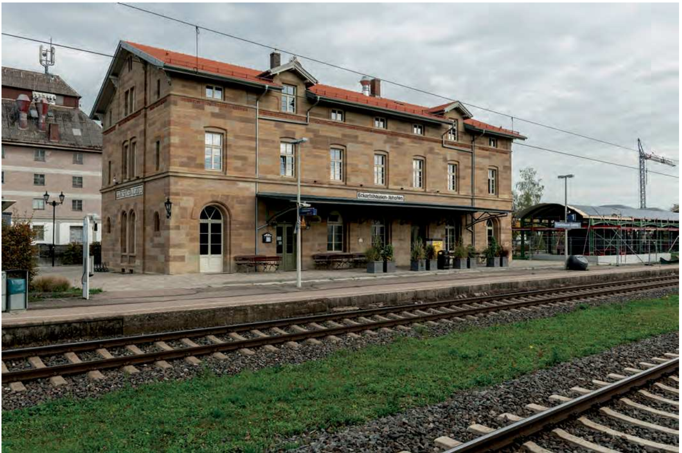
Ein repräsentativer Bau des 19. Jahrhunderts auf dem Land: der wiederbelebte Bahnhof Eckartshausen-Ilshofen
