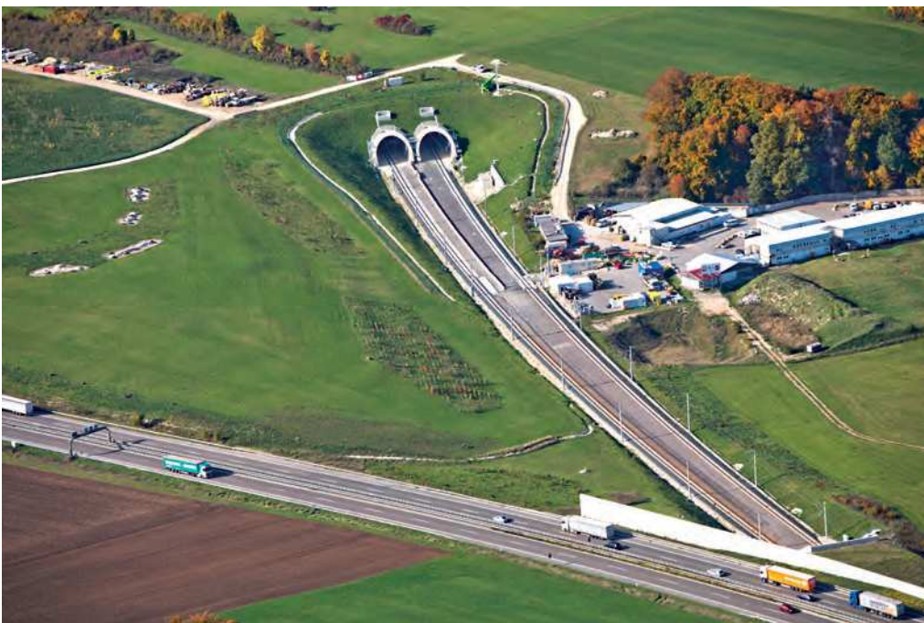
Das Ostportal des 4847 Meter langen Steinbühltunnels liegt bei Hohenstadt. An das Nordwestportal schließt direkt die Filstalbrücke an.
