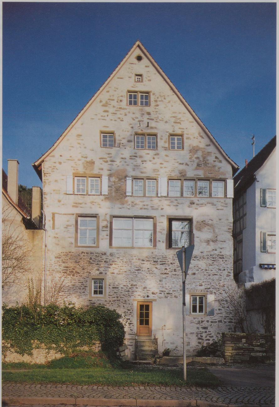
*Stadtmaueransicht mit Steinfassade aus verschlammtem Bruchsteinmauerwerk.*
