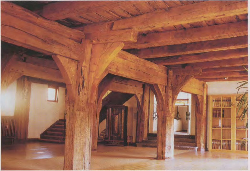
Die beachtenswerte Holzkonstruktion im Rathaus der Stadt Niedernhall: dreischiffige Halle im ersten Obergeschoss.
