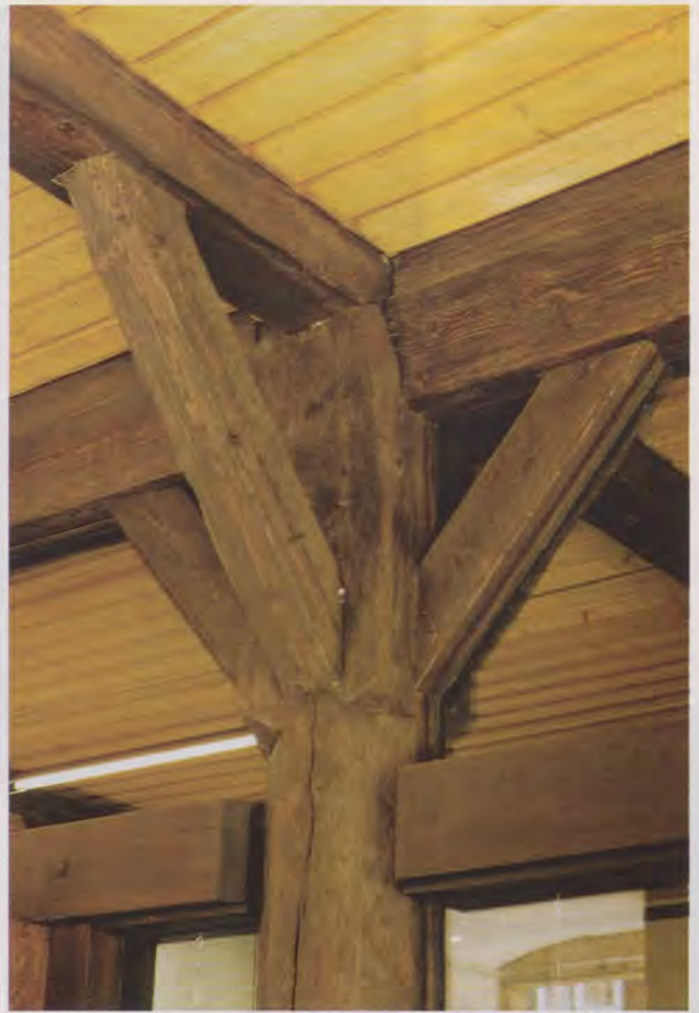
Hölzerne Trag- und Verbindungselemente im Erdgeschoss des Kornhauses der württembergischen Amtsstadt Kirchheim unter Teck. Rechts das Rathaus dieser Stadt mit einem überdimensionierten Dachreiter.
