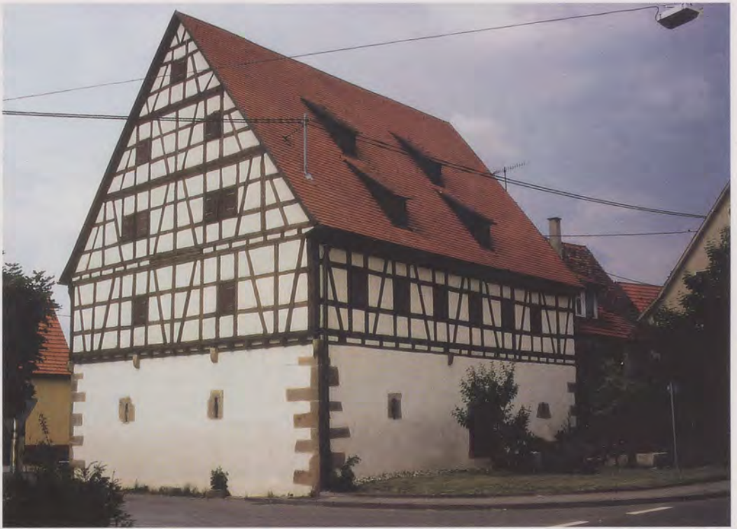
Ansicht und Strukturplan (unten rechts) der Zehntscheune in Neckartenzlingen: Mauerwerk-Scheune mit aufgesetztem Kornspeicher aus Fachwerk.
