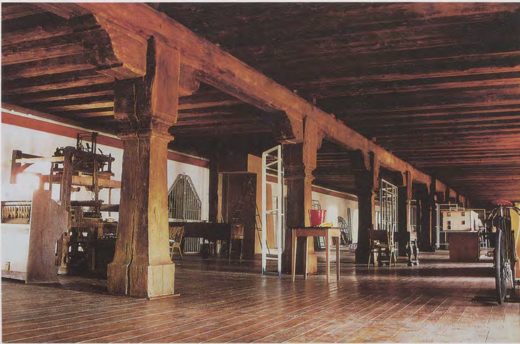
Gewaltig sind die Ausmaße der Zehntscheune in Hardheim im badischen Frankenland, des sogenannten Schüttungsbaus. Blick in die Erdgeschosshalle mit Mittellängs-Unterzug und Stützenreihe.
