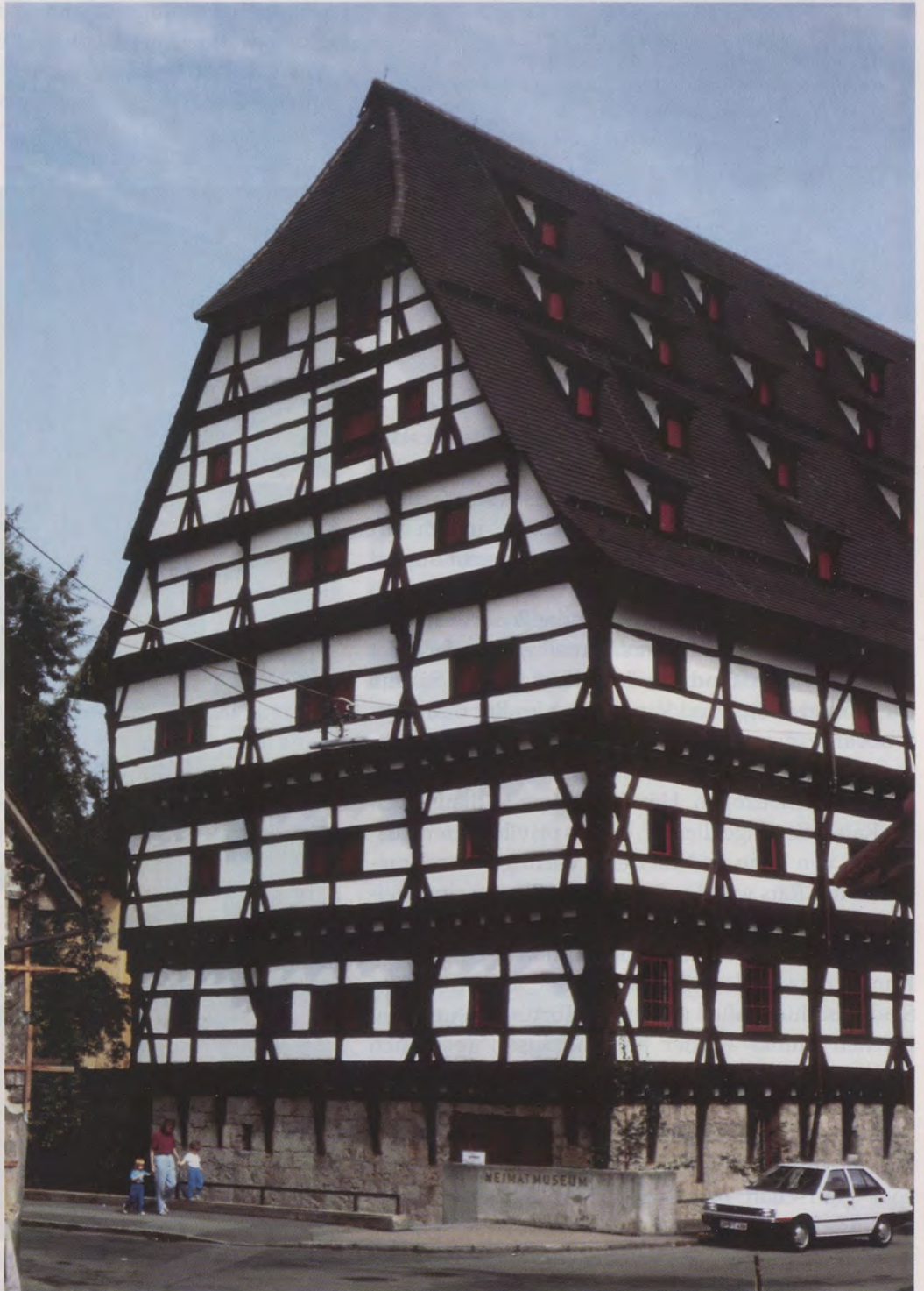
Der monumentale «Bau» in Geislingen an der Steige, eines der schönsten Kornhäuser im Lande. Die durchgehend dreischiffige Gliederung im Inneren bei neun Querzonen ist außen in den Fachwerkwänden gut ablesbar.
