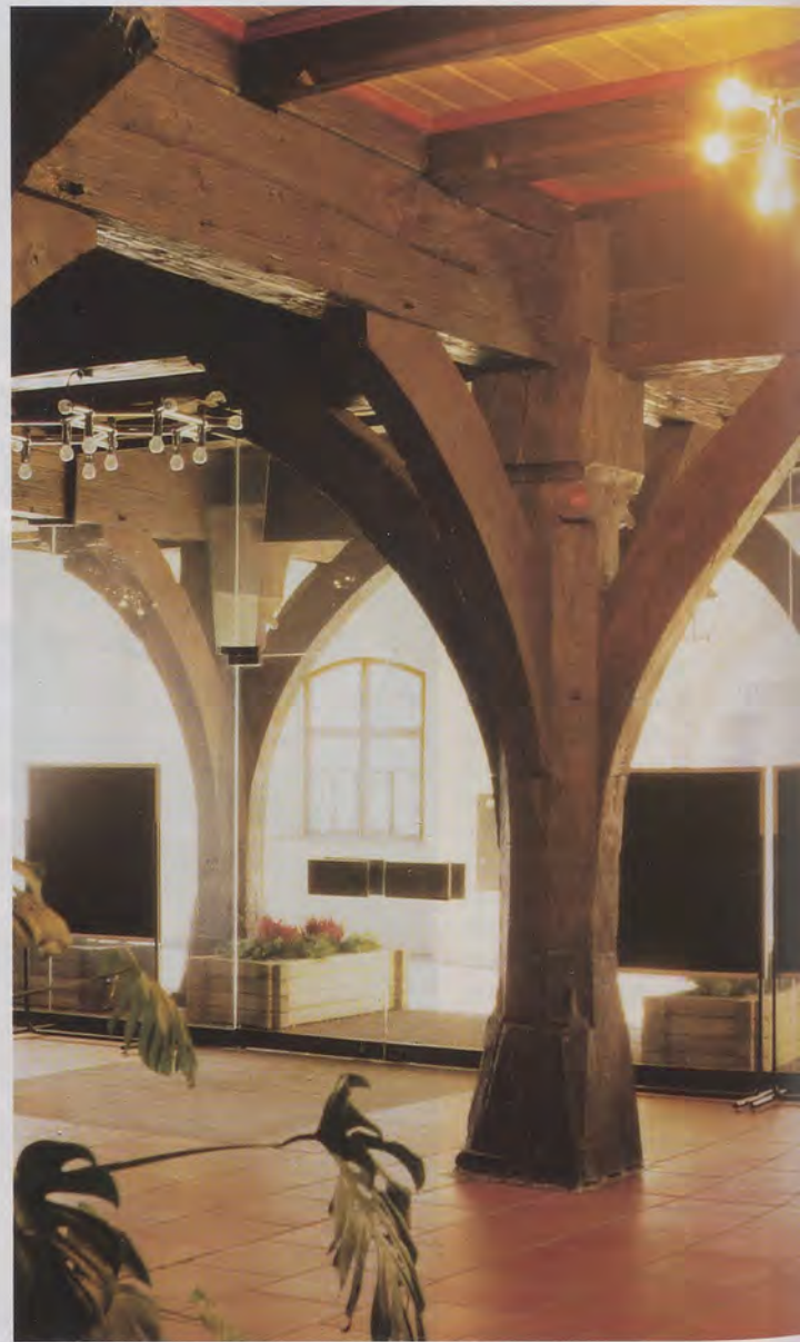
Das frühere Kornhaus in Riedlingen dient heute als Rathaus. Erdgeschoss mit Holzstützen und geschweiften Kopfbändern.
