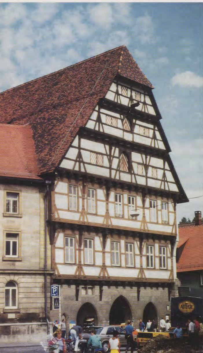
Amtshaus des Spitals der Reichsstadt Schwäbisch Gmünd. Alemannische Holzbauweise auf massivem Erdgeschoss.
