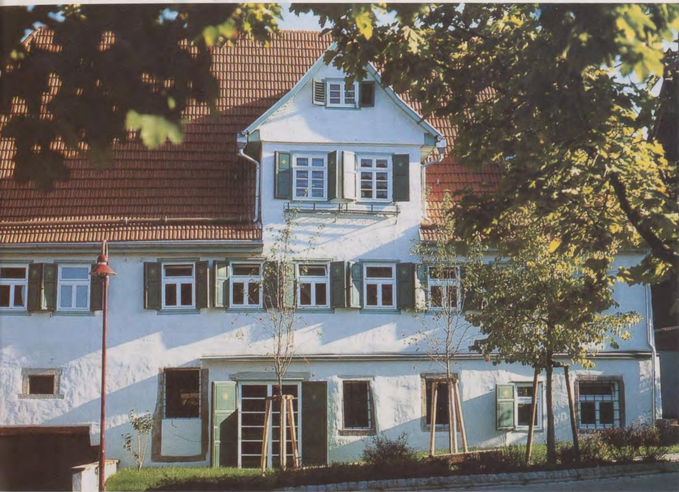
Die Straßenansicht der Alten Mühle in Eberdingen zeigt neben modernen Ergänzungen die typische Fachwerk-Putzfassade mit den Kreuzstockfenstern und Klappläden des 19. Jahrhunderts. Auf dem kleinen Bild ist der Zustand vor der Sanierung zu sehen.
