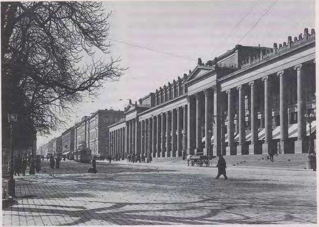
Der gesamte Bau des Kronprinzenpalais wurde über einem vorkragenden Kranzgesims auf Volutenkonsolen durch ein flaches Zinkdach abgeschlossen, das von einer umlaufenden Attika völlig verdeckt wurde.
