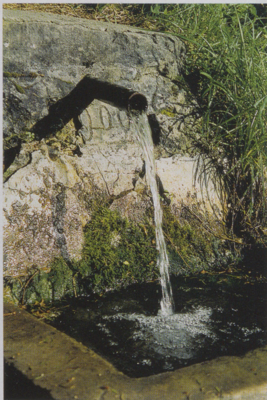
Rechts: Solche schlichte Quelfassungen sind erhaltens- und nachahmenswerte Kleindenkmale. Dieser aus dem Jahr 1906 stammende Brunnen ist im Rottal bei Großserlach (Rems-Murr-Kreis) aufgenommen.
