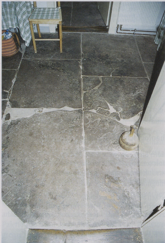
Freudenstadt-Obermusbach, Altes Schul- und Rathaus Blick in die Küche mit dem originalen Steinplattenboden
