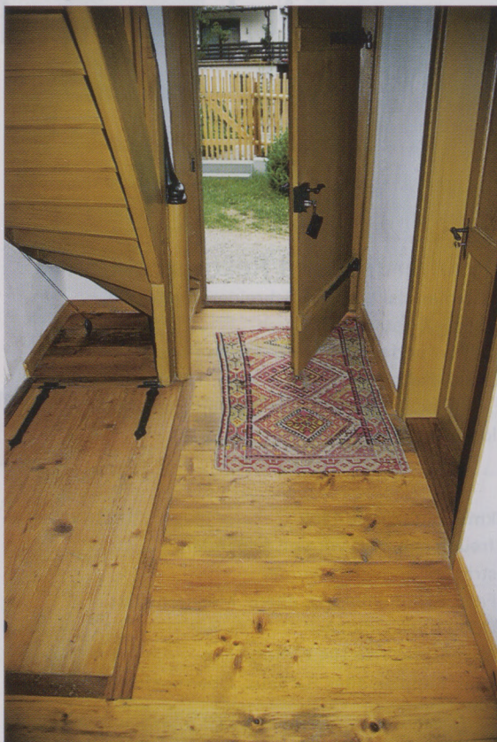
Überlingen-Goldbach, Hauseingang des Mesnerhauses mit originalem Dielenboden
