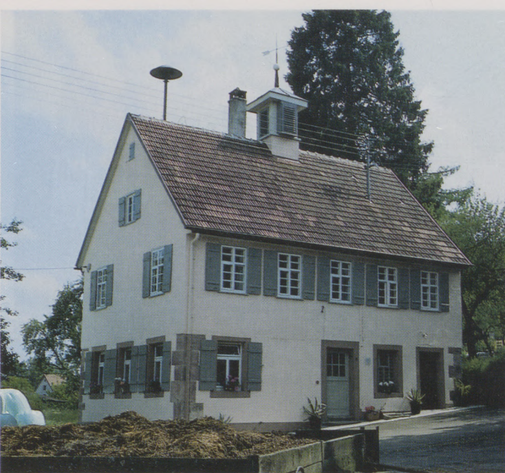
Freudenstadt-Obermusbach, Altes Schul- und Rathaus Giebelansicht mit steinigem Erdgeschoß und verputztem Fachwerk im Obergeschoß
