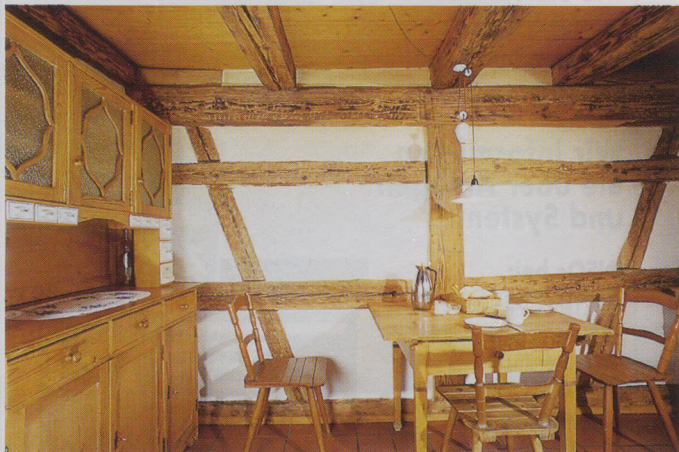
Heiningen, Ringstr. 10 Sichtfachwerk in einer Stube im Obergeschoß
