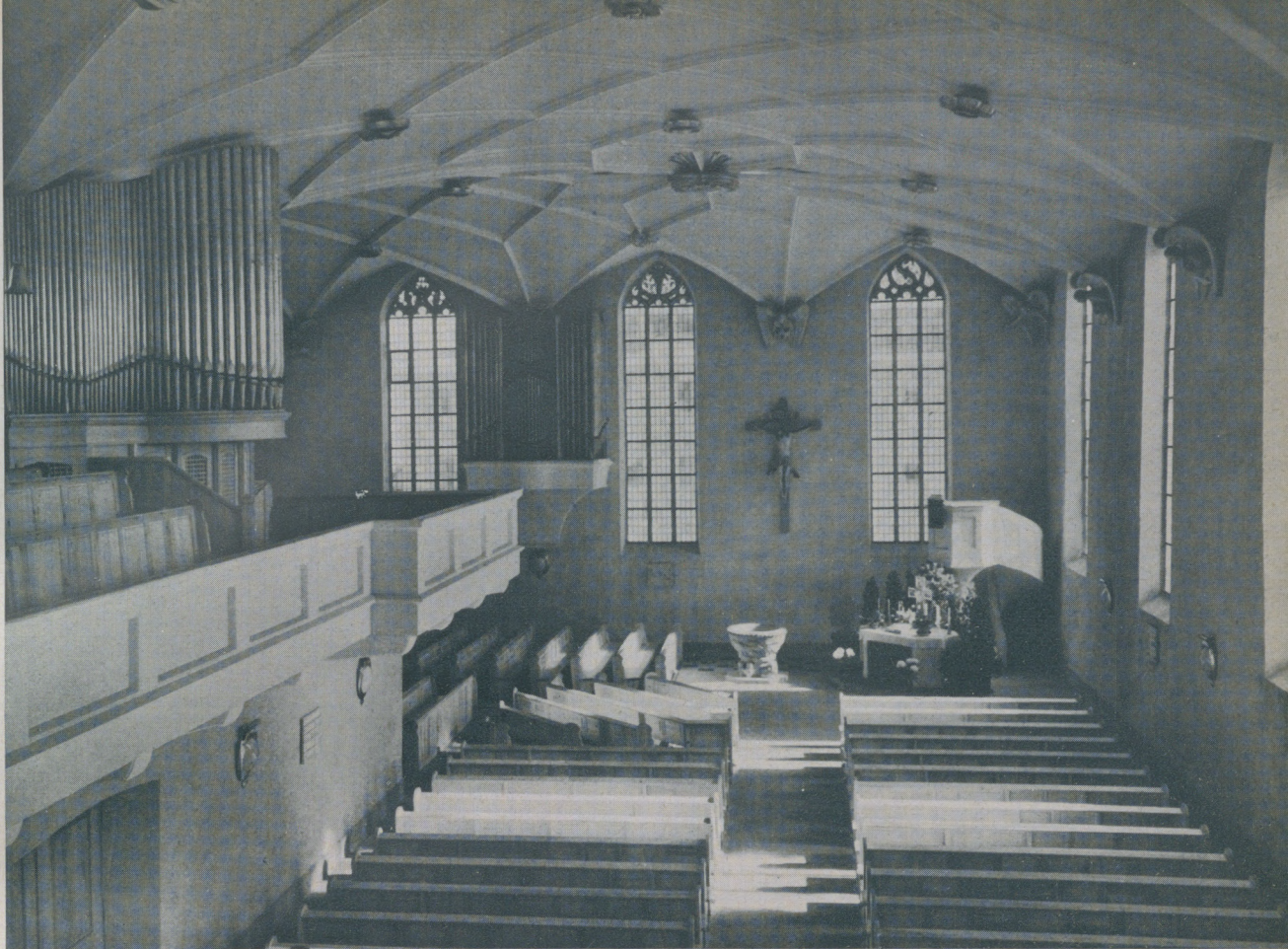
Stadtkirche in Freudenstadt nach der Instandsetzung
