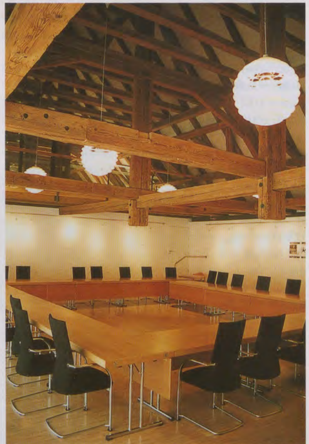
Blick in den Ausstellungsraum der Alten Kelter in Grunbach. Man erkennt den historischen Dachstuhl mit Hängewerk.
