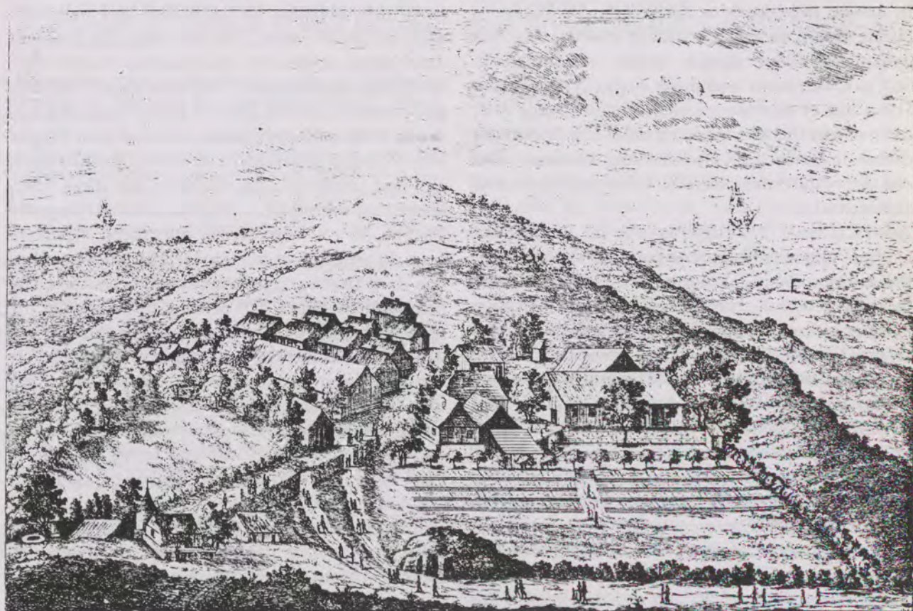
So hat Neu-Herrnhut auf St. Thomas ausgesehen. Das Gebäude vorne rechts ist die Kirche, dazu kommen das Familienhaus – das langgestreckte Gebäude links –, Schreiner-Werkstatt, Vorrats- und Backhaus, Zuckerkochhaus und oben links die Negerhäuser.
