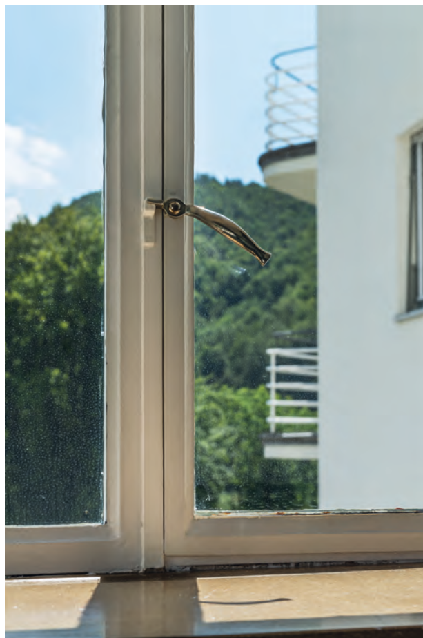
Eines der wenigen noch erhaltenen Fenster mit originalem Griff. Schnecks Buch zum Fensterbau erschien in sieben Auflagen von 1932 bis 1963.
