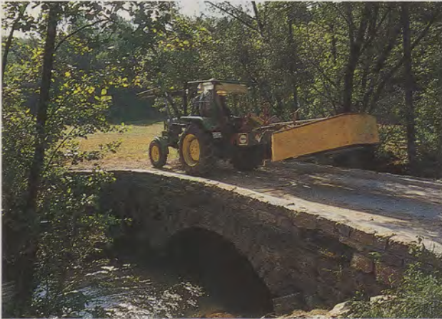
Nach der Sanierung ist diese alte Brücke im Buchenbachtal, Landkreis Ludwigsburg, auch mit Traktoren befahrbar.
