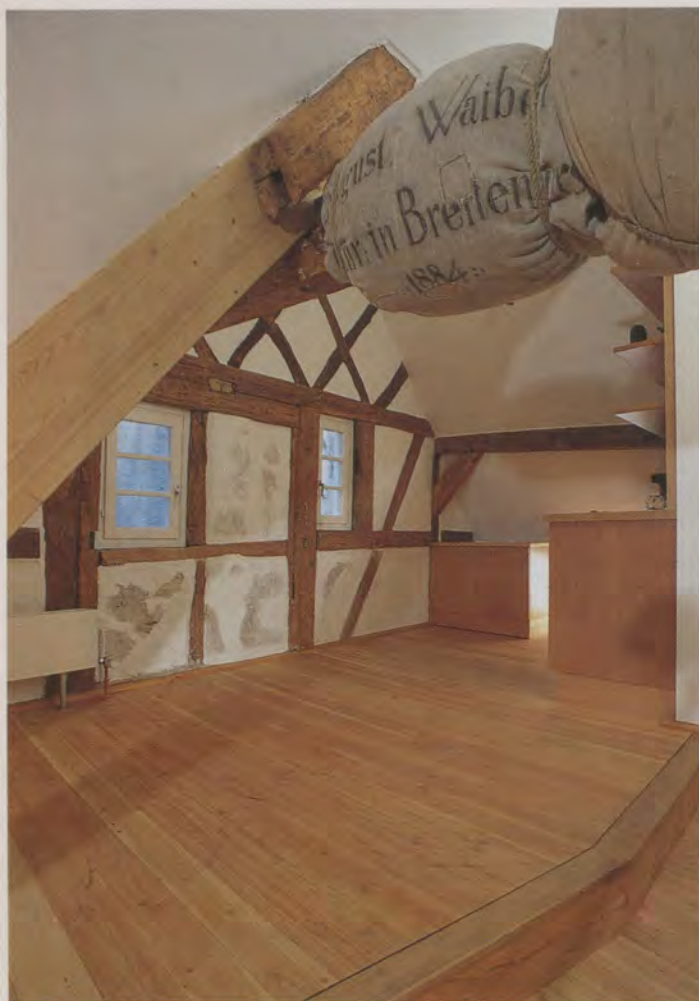
Neue Geschäftsstelle Weberstraße 2 – Schiefe Böden mußten durch Absätze ausgeglichen und störende Balken umwickelt werden.
