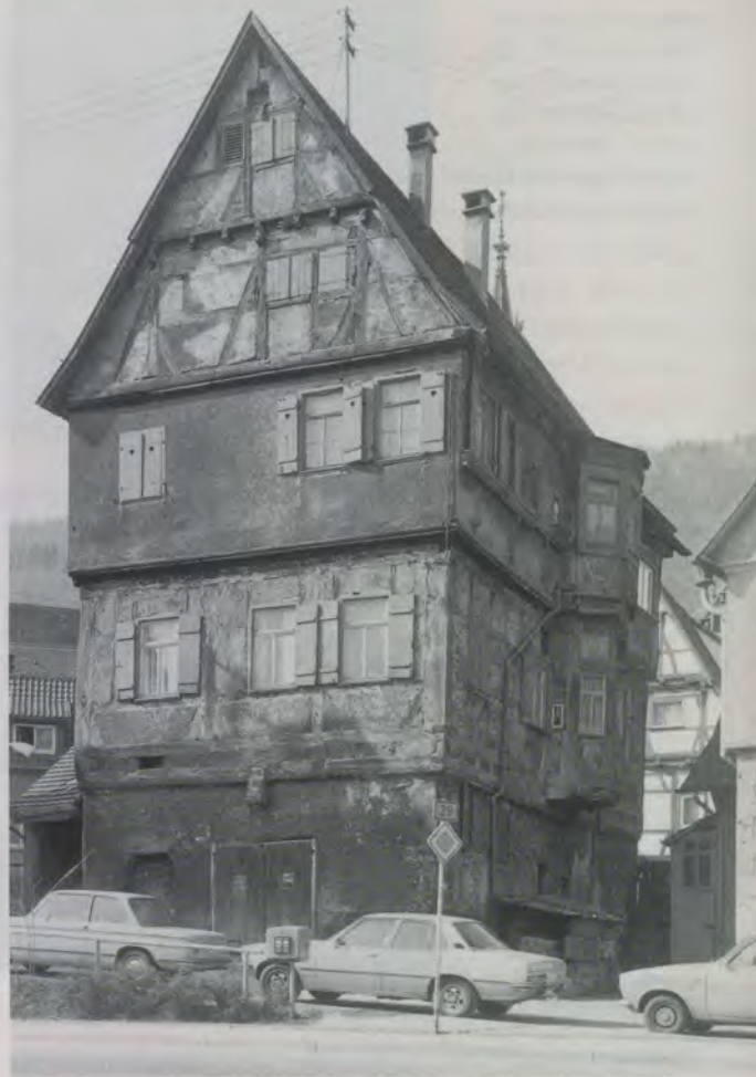
Das «Haus am Gorisbrunnen» in Bad Urach vor der Restaurierung.
