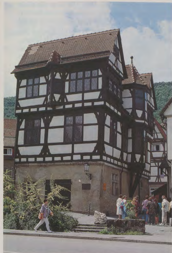
Dasselbe Gebäude saniert. Auffällig die Rekonstruktion der früheren Dächer.
