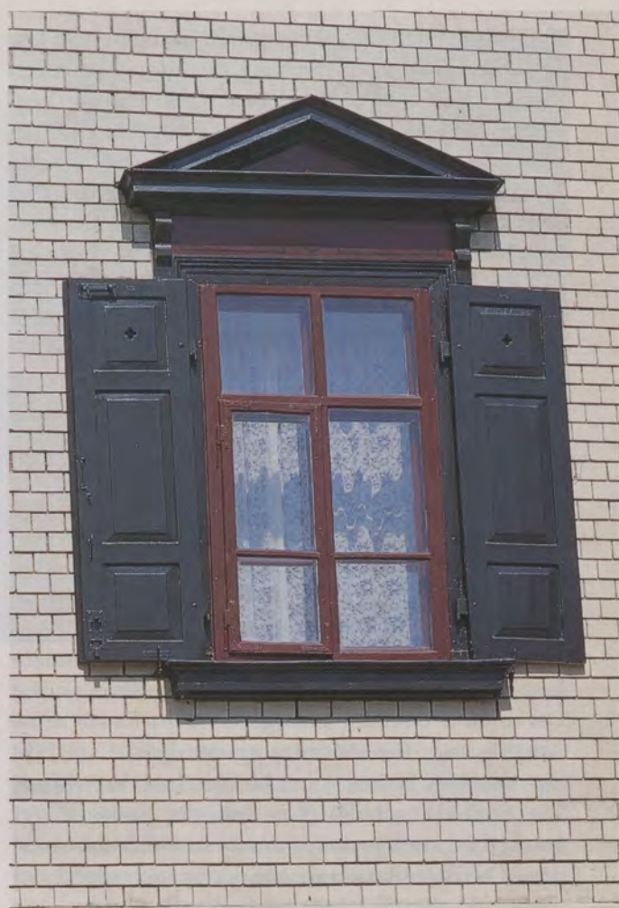
Oben: Bau aus der Gründerzeit in Schwäbisch Gmünd: Fassadenausschnitt mit Fenster, Klappläden und Bekrönung. Unten links: Treppenhausfenster mit Ornamentverglasung. Linke Seite, unten rechts: Eingang mit Ornamentfliesen auf dem Boden.
