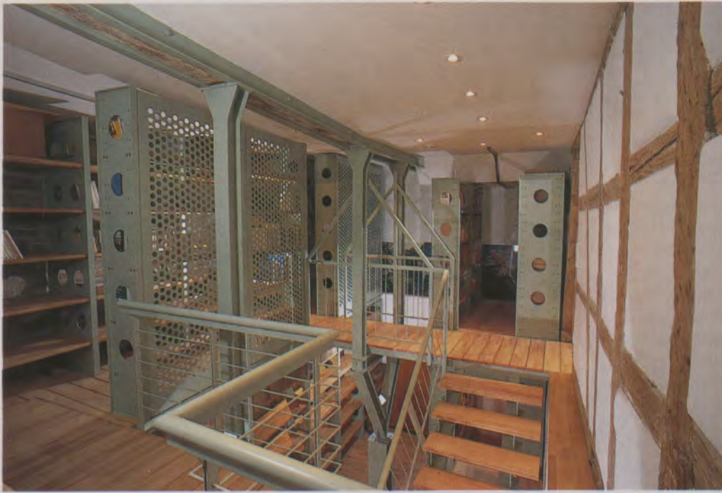
Der Einbau der Bibliothek in Stahlkonstruktion über zwei Geschosse. Hier der obere Teil: die Wangen der Bücherregale mit großen, die Rückseiten mit kleinen Löchern.
