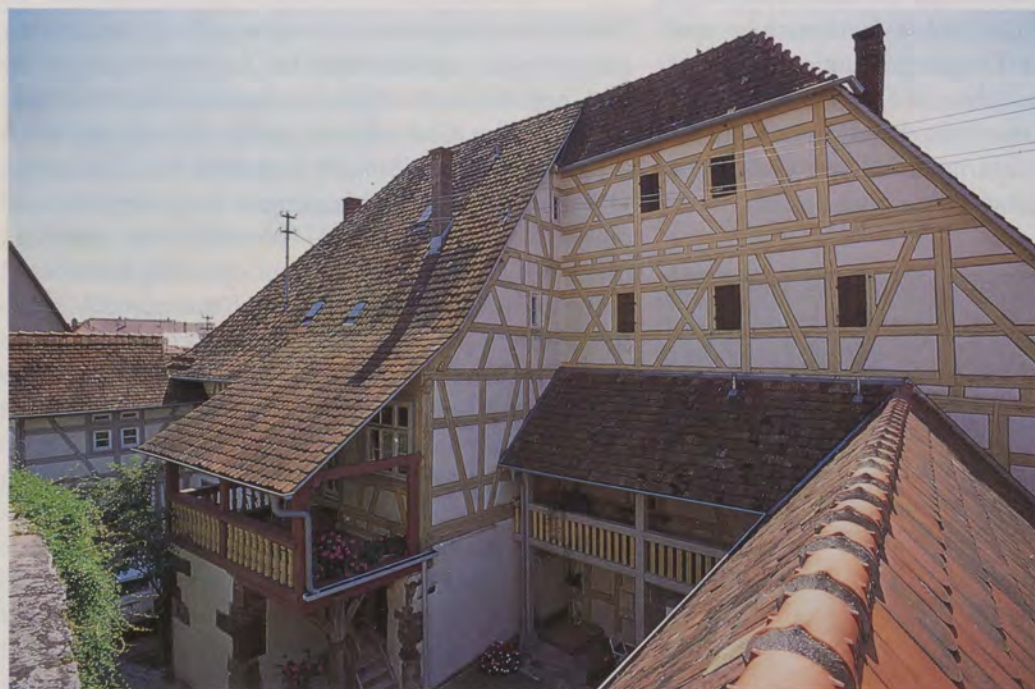
Oben rechts: Durch die Flurküche im ersten Obergeschoß konnte die alte Raumeinteilung bewahrt werden.
