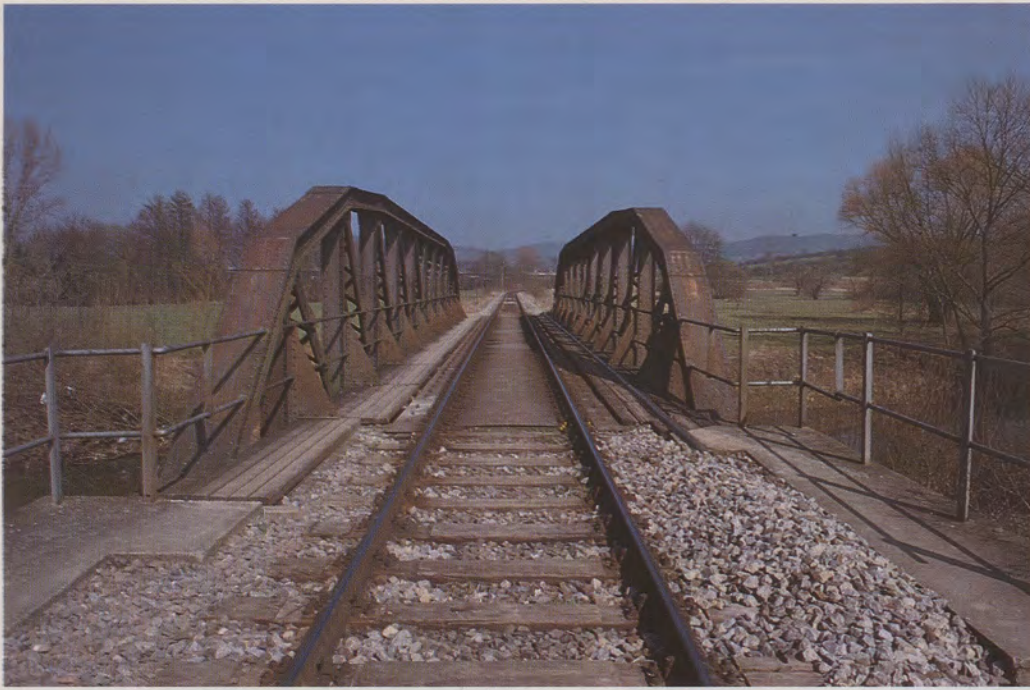
Stahlgitterbogenbrücke aus der Entstehungszeit der Bahnlinie. Mit ihr wird nordöstlich von Schorndorf im Naturschutzgebiet Morgensand-Seelachen die Rems überquert.
