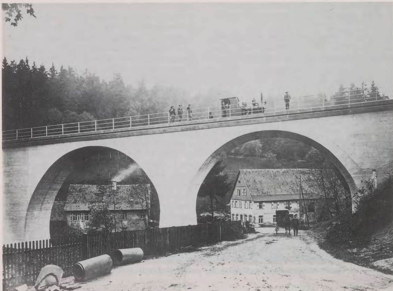
Alte und neue Zeit begegnen sich: oben die Eisenbahn, unten die Postkutsche. Aufnahme aus der Zeit des Bahnbaus. Heute wartet der Viadukt beim Bahnhof Laufenmühle auf seine Sanierung.
