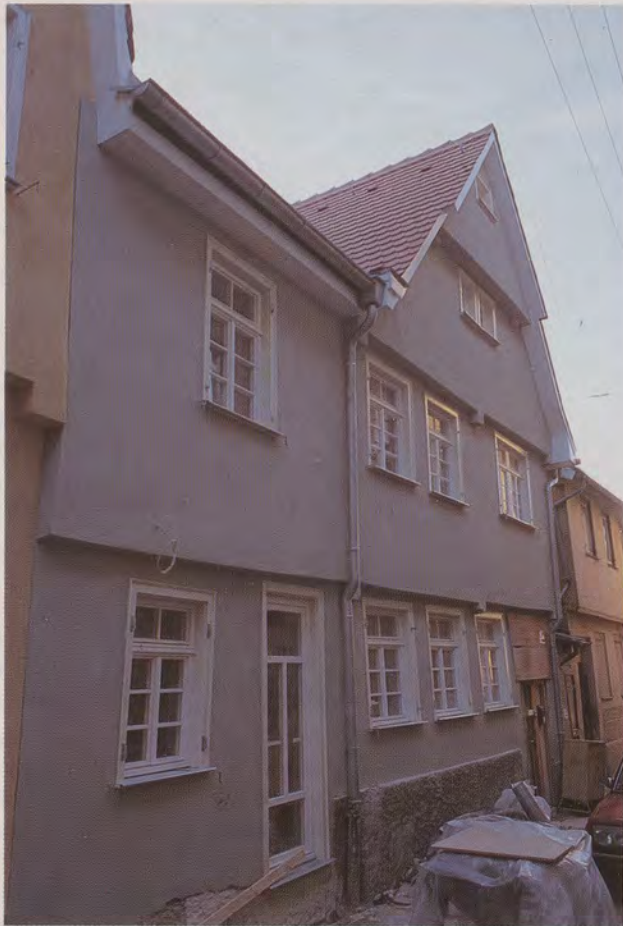
Dem Gebäude Weberstraße 2 fehlt noch die neue Haustür und der Sockelputz.
