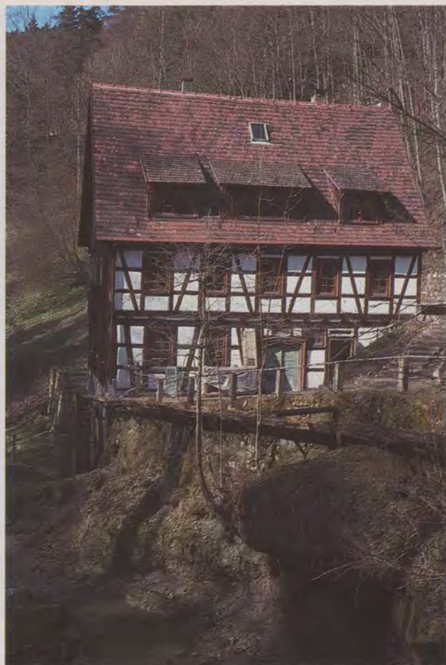
Die Klingenmühle tief unterhalb der Bahn im Naturschutzgebiet Wieslauffschlucht. Diese Mühle inspirierte Justinus Kerner, damals Oberamtsarzt in Welzheim, zu seinem Gedicht: «Der Wanderer in der Sägmühle».
