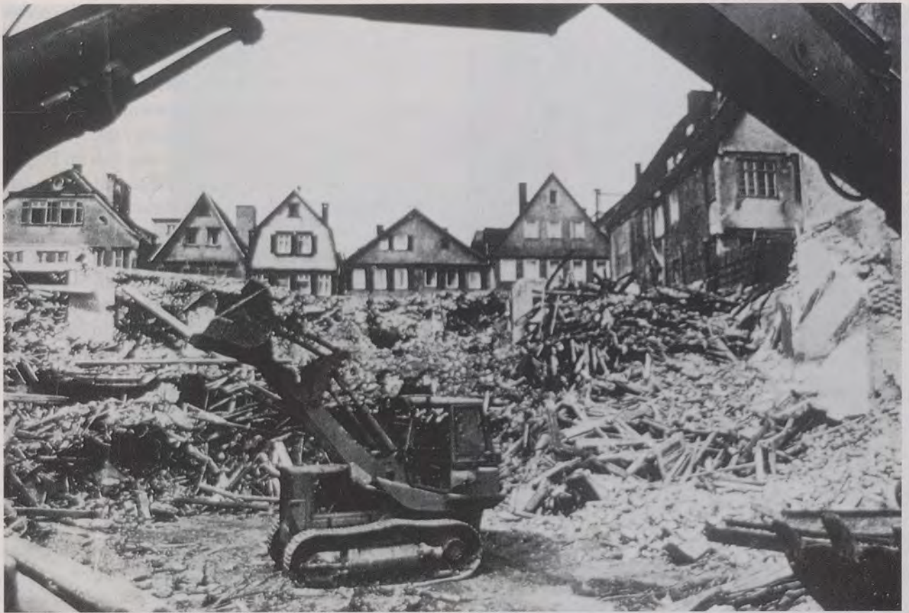
Die Bagger graben sich in Häuser und ins Erdreich; hier werden die Baugruben für die Gebäude an der Theodor-Heuss-Straße und für die U-Bahn ausgehoben.
