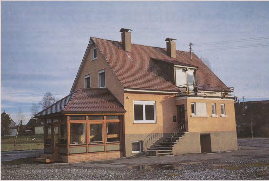
In einem ehemaligen Wohn- und Bürogebäude am Rande von Wilhelmstorf wurde das Naturschutzzentrum ohne bauliche Veränderungen eingerichtet.
