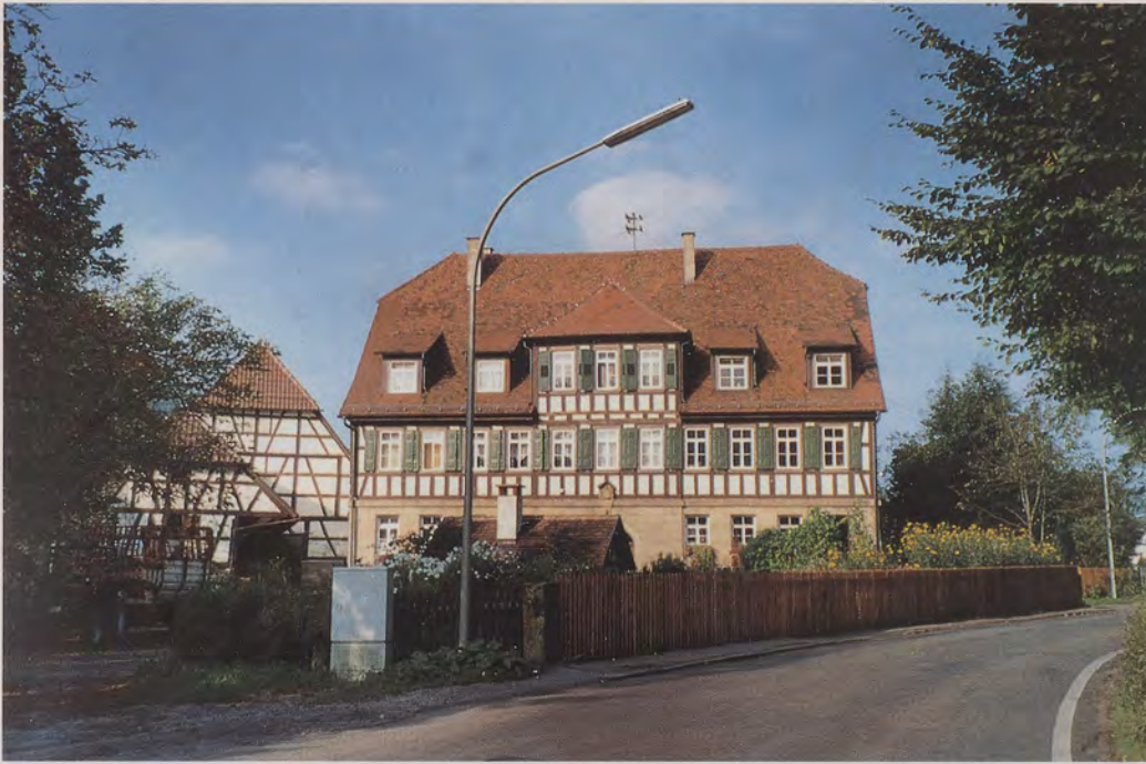
Die Rümelinsmühle am Stadtrand von Murrhardt, die einzige Mühle weit und breit, die nur mit Wasserkraft angetrieben wird. Das Wasserrad datiert von 1799.
