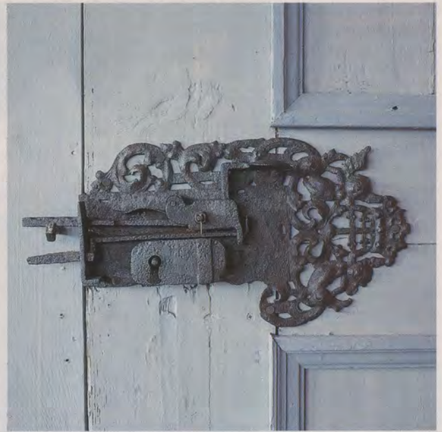
Rittersaal im zweiten Obergeschoß des Schlosses Neunstetten, oben ein kunstvoll geschmiedetes Türschloß, unten ein Türgriff, der als Fisch ausgebildet ist.
