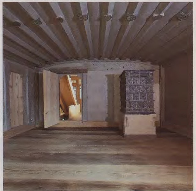
Bohlenstube von 1464/65 mit Kachelofen im ersten Obergeschoß des Hauses Graben 15 in Rottweil.
