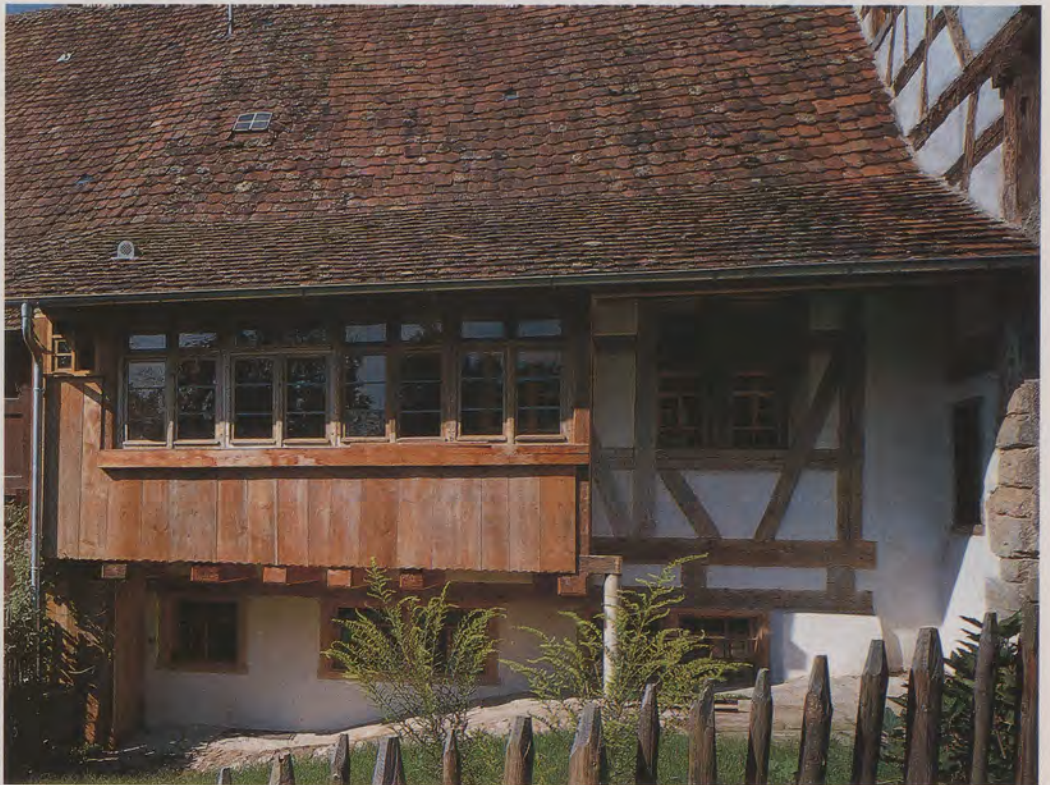
Haus Graben 15 in Rottweil-Altstadt von Osten her, der Straße abgewandt.
