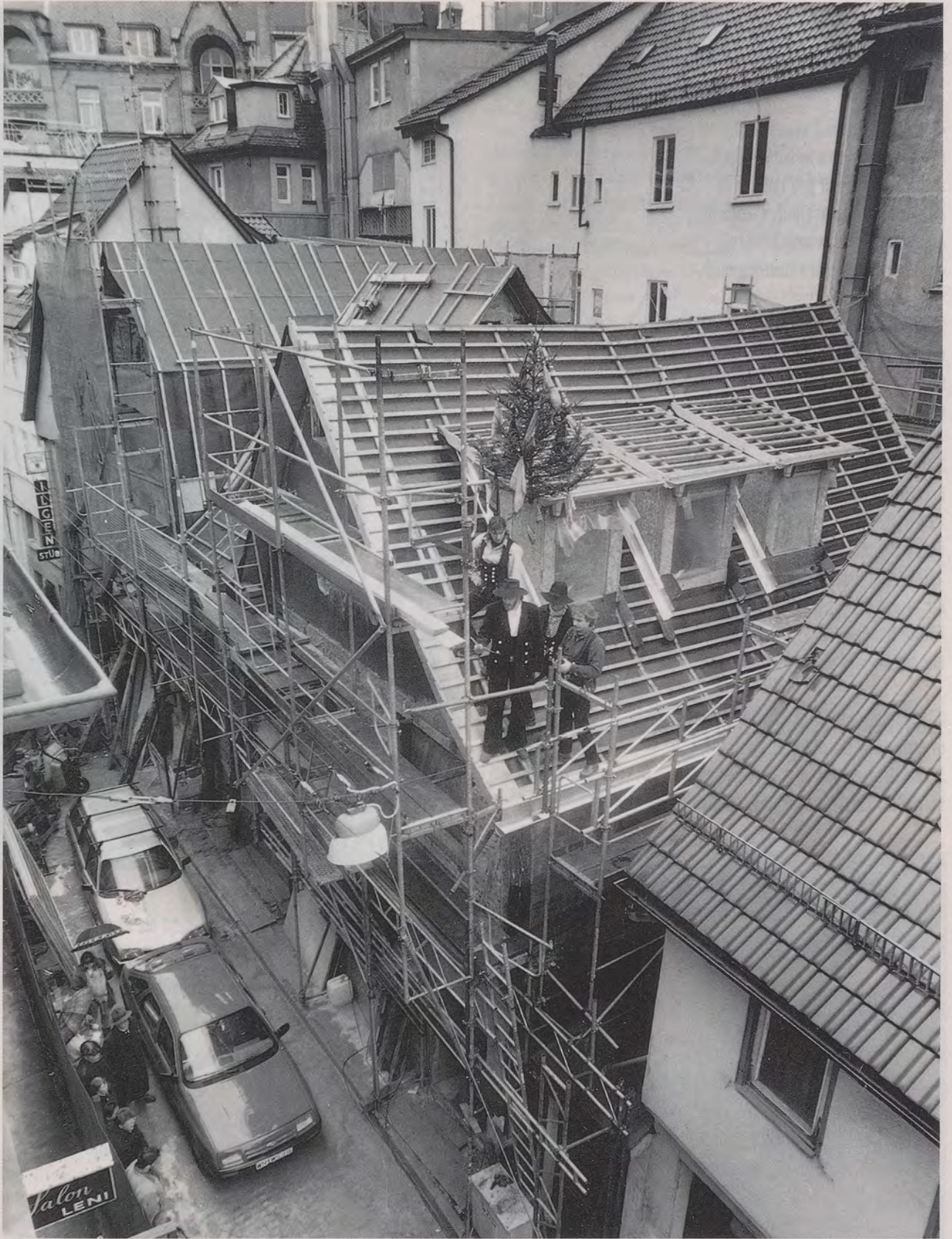
18. November 1994, Blick von der gegenüberliegenden Seite der Weberstraße auf die «Patienten», auf die sanierungsbedürftigen Häuser im Stuttgarter Leonhardsviertel. Der Zimmermeister Oliver Bäßler liest den Richtspruch vor, unten links erkennt man einige der Teilnehmer dieser Zeremonie. Auf der nächsten Seite: Das Glas wird zum zweiten Male hinuntergeworfen, da beim ersten Male nur der Fuß abgebrochen ist.
