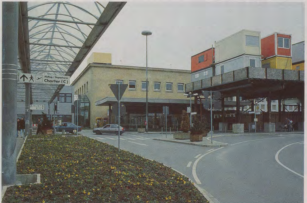
Oben rechts: Fassade von der Rollbahnseite aus gesehen, um 1952. Der gläserne Toweraufsatz (1950) zerstörte das ausgewogene Erscheinungsbild des Hauptgebäudes.
