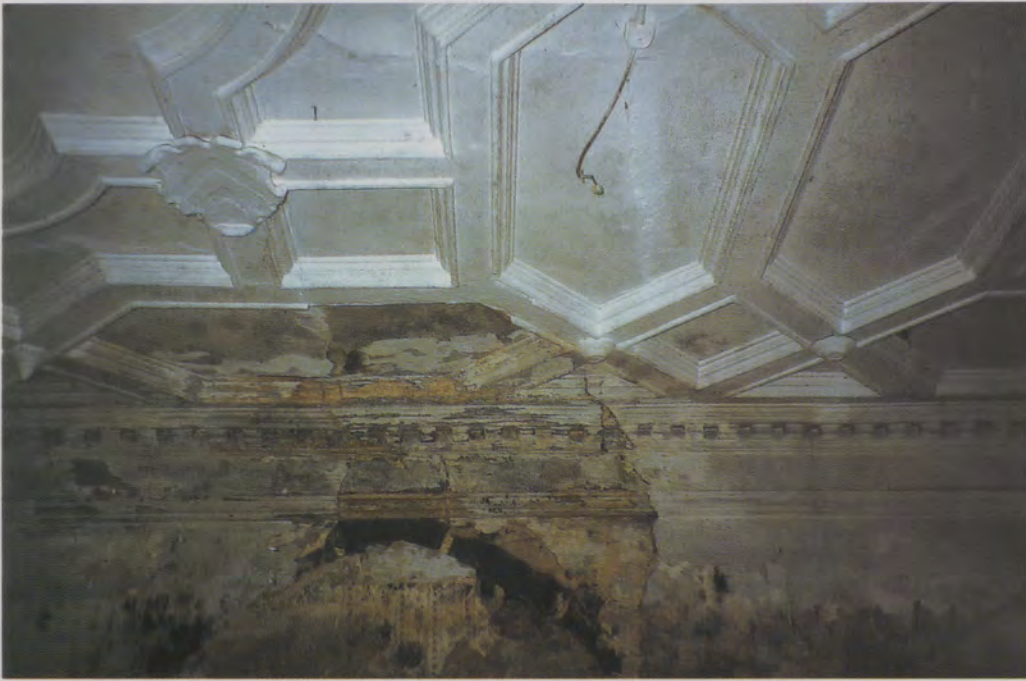
Schloßkirche Schmie- delfeld: Stuckdecke des Kirchenschiffs, Detail.
