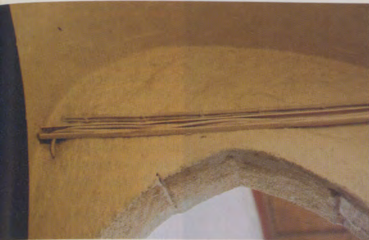
Der asymmetrische Mauerdurchbruch in der Nordwestecke der Turmkapelle dokumentiert, daß hier erst nachträglich, in gotischer Zeit, ein Zugang geschaffen wurde.
