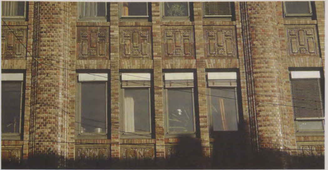
Bau 19, Detail aus der Fassade.
