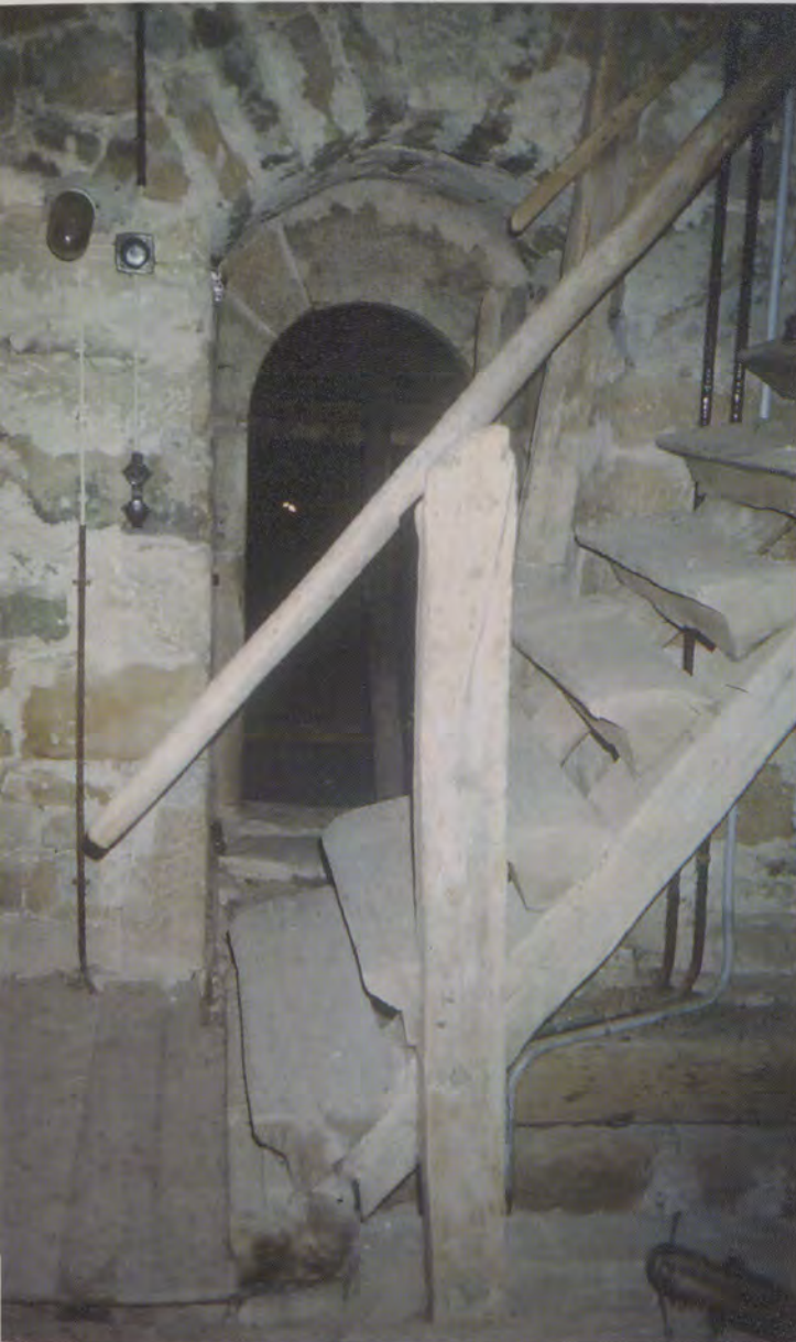
Der romanische Turmeingang von der Turminnenseite aus betrachtet. Im Hintergrund der Dachstuhl des Langhauses.
