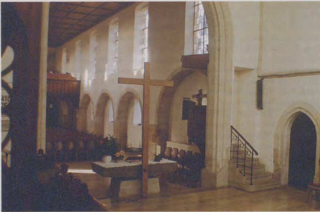
Blick vom Chor auf die nördliche, 1627 vermauerte Arkadenreihe des Langhauses. Der große erste Arkadenbogen bildete die Verbindung zum «alten Chor», der nach Eyselin aus der einstigen «Hofkapelle» hervorgegangen ist.
