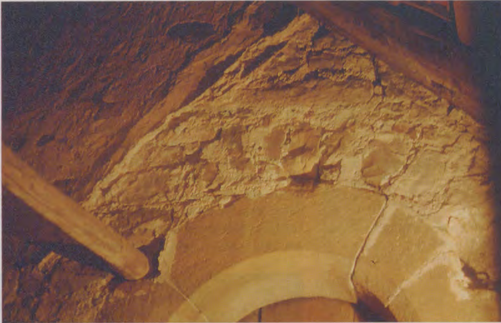
Über dem romanischen Turmeingang sieht man noch den Ansatz eines Querhausdaches, das mit der Errichtung des gotischen Hochchores 1515 beseitigt werden mußte.
