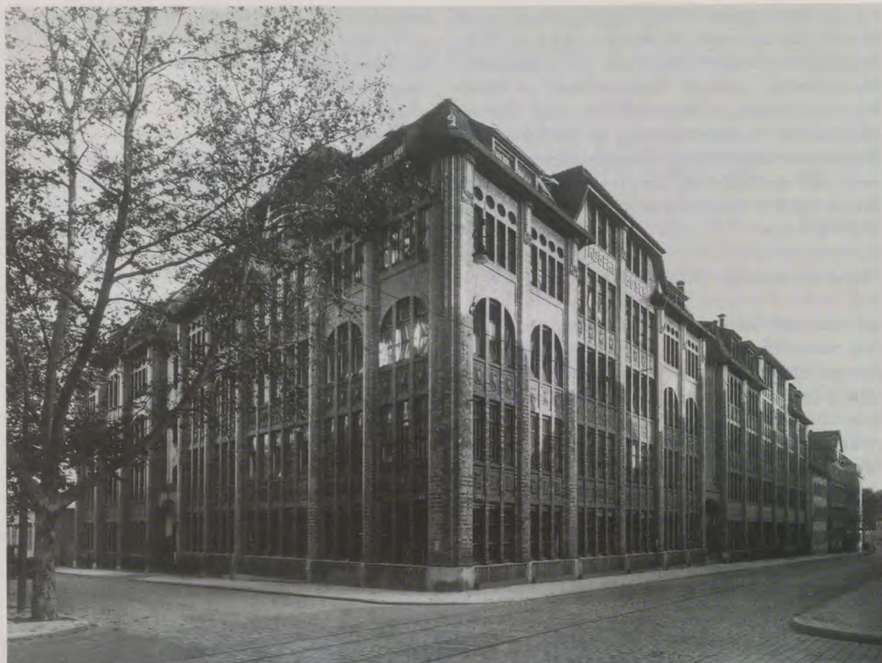
Die Bauten entlang der Forst- und Seidenstraße, Bau 17, 18 und 19, um 1911. Der Eckbau hat heute eine andere Fassade.
