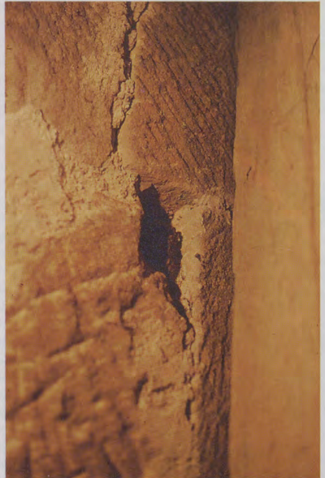
Romanischer Turmeingang, Türinnenseite. Die Bilder zeigen das linke und das rechte Aufnahmelager für eine Querstange, mit der die Türe von der Turminnenseite aus verrammelt werden konnte. Da der Schlüssel zu dem barocken Türschloß verlorenging, hat man eine quadratische Öffnung in das Türblatt gesägt.
