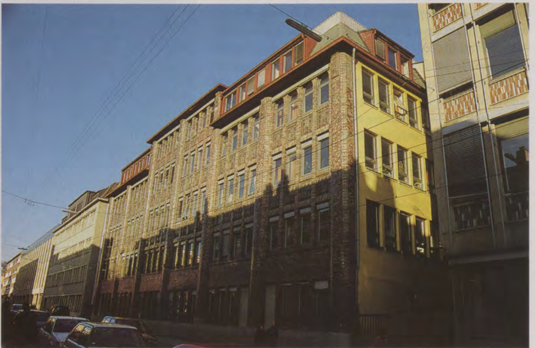
Bau 19 in der Seidenstraße 20, wie er sich noch heute präsentiert.
