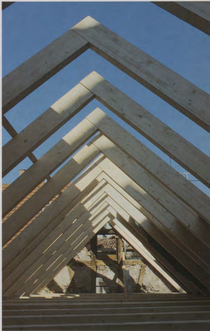
Blick auf die Dachbalken in der Richtstraße 3 im Stuttgarter Leonhardsviertel; bald wird den Giebelbalken ein Richtbäumchen schmücken.
