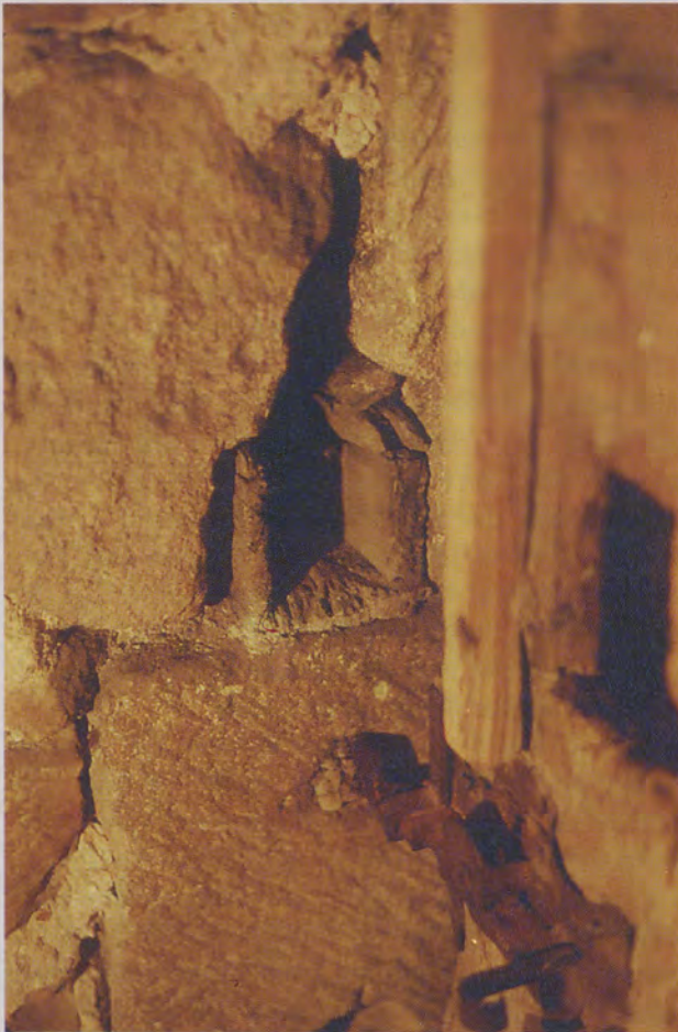
Romanischer Turmeingang, Türinnenseite. Die Bilder zeigen das linke und das rechte Aufnahmelager für eine Querstange, mit der die Türe von der Turminnenseite aus verrammelt werden konnte. Da der Schlüssel zu dem barocken Türschloß verlorenging, hat man eine quadratische Öffnung in das Türblatt gesägt.
