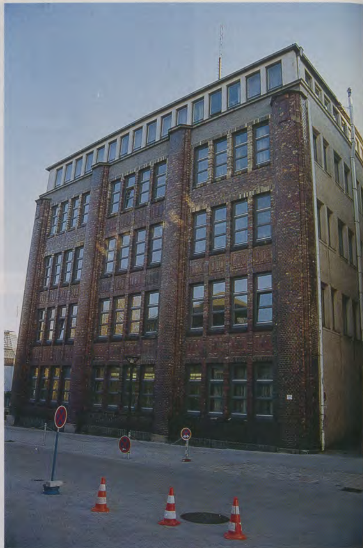
Heutiger Zustand des Gebäudes Forststraße 7, Bau 17.
