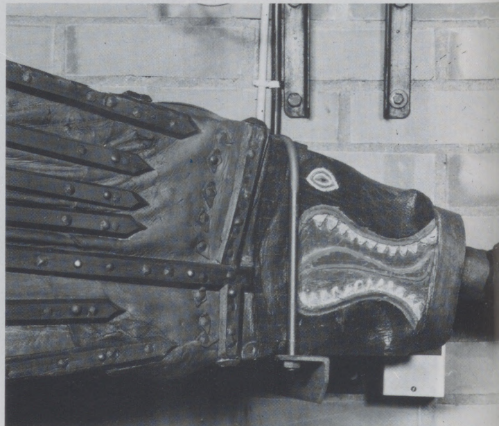
Esse mit Blasebalg; im Vordergrund steht ein Fußhammer. Unten das verzierte Mundstück des Blasebalgs.
