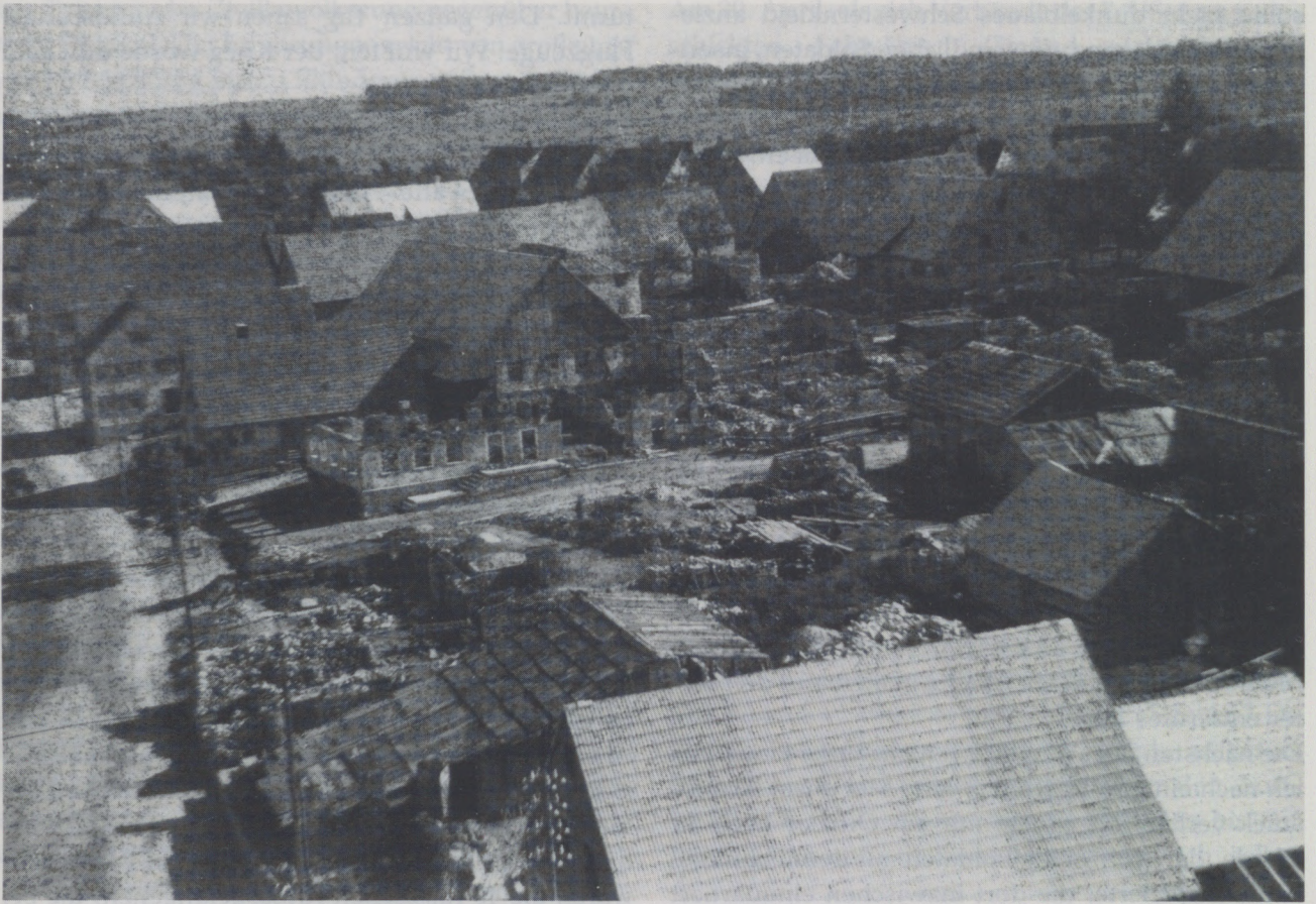
Westerheim: Blick auf die Donnstetter Straße
