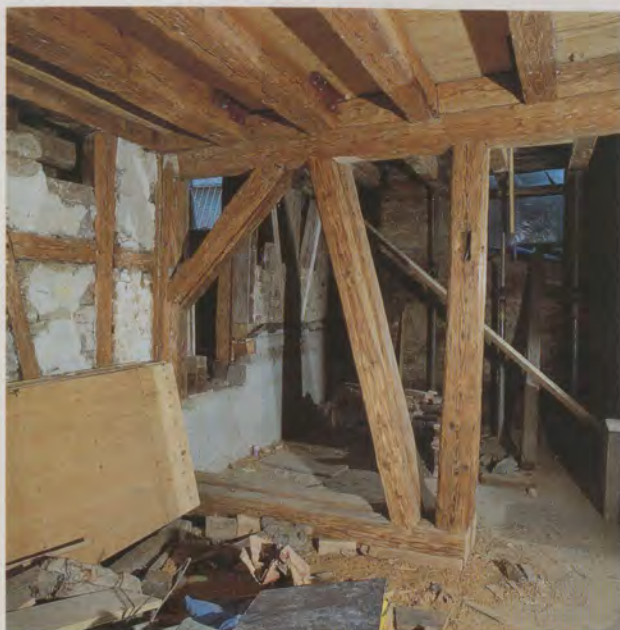
Ein Blick in den neuen Veranstaltungsraum, wo diese Balkenkonstruktion den künftigen Kucheneinbau etwas abschirmt.
