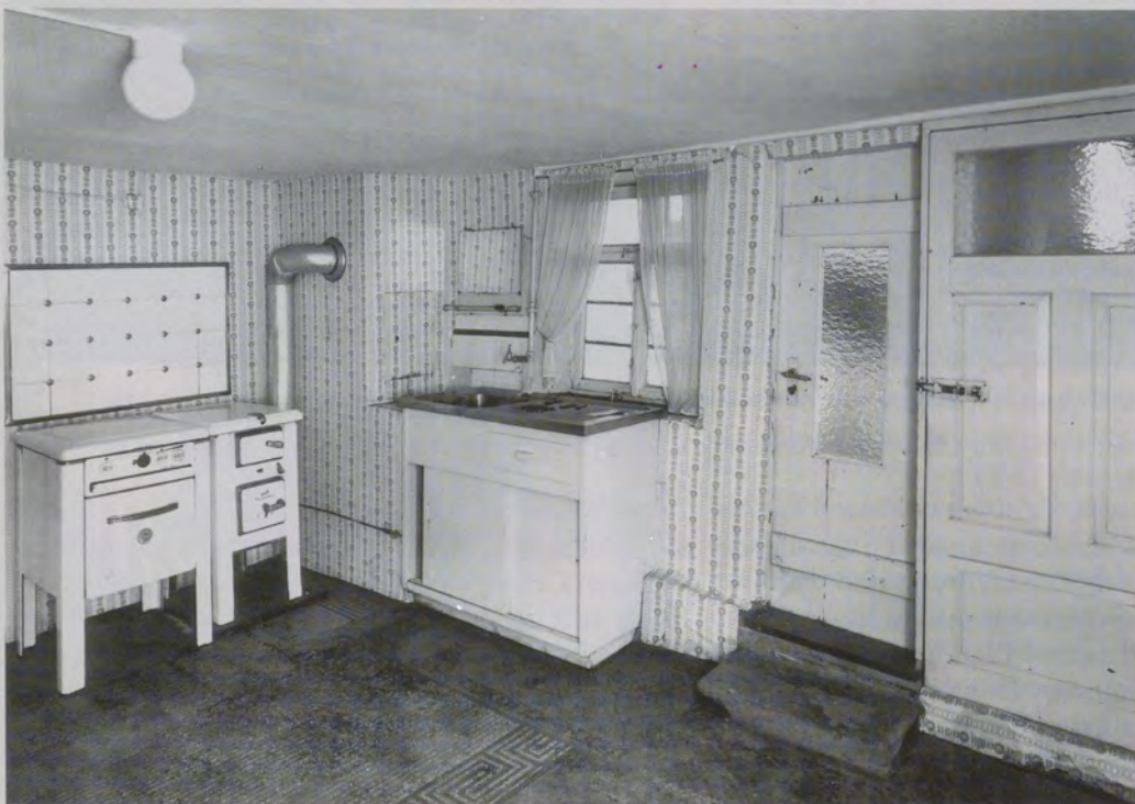
Zustand der Küche im Erdgeschoß des Wohnhauses vor dem Umbau zum Museum.
