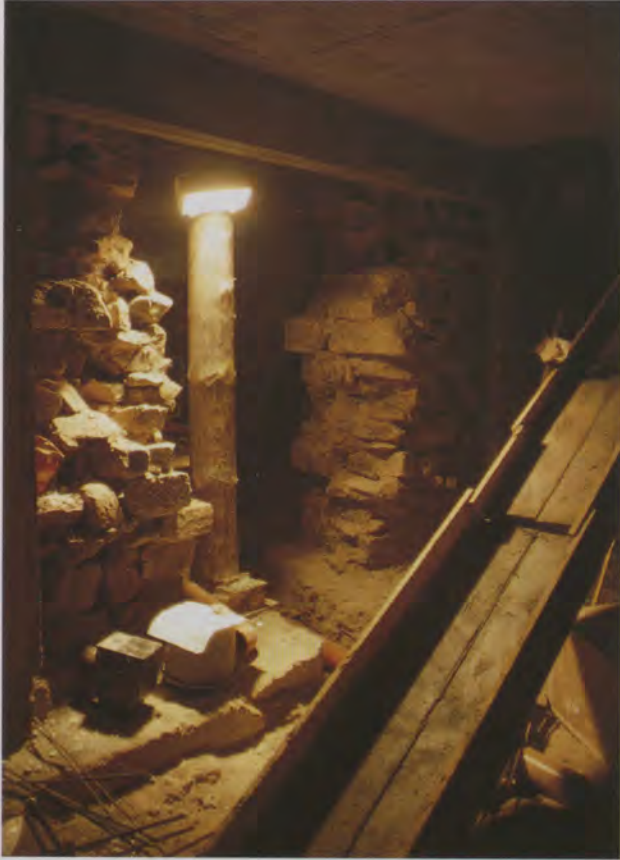
Die mächtige Mauer zwischen Weberstraße 2 und Richtstraße 1 konnte nicht als Tragwand genutzt werden, deshalb wurde ein Unterzug betoniert. Die Mauer wird als musealer Teil erhalten.
