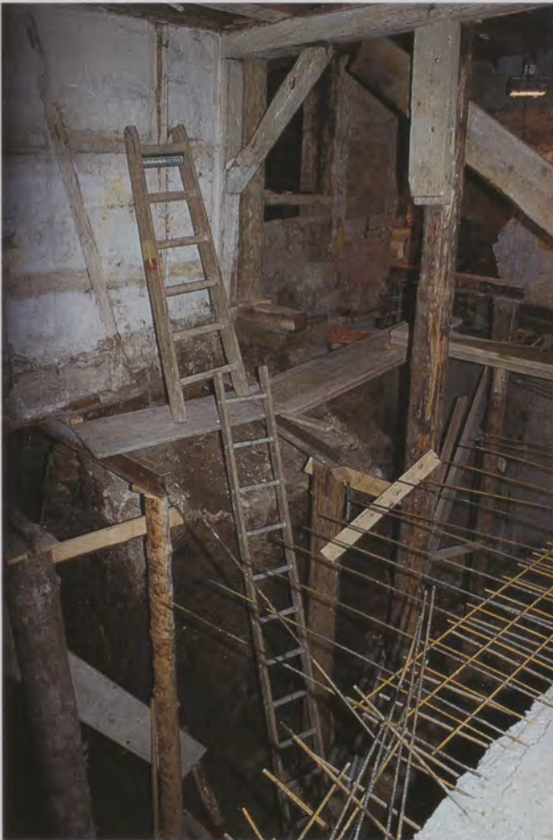
Unterfangungsarbeiten im Bereich Richtstraße 1, künftiges Stuhl- und Tischlager und Technikraum. Die Stahlbetondecke wird in Abschnitten gebaut.
