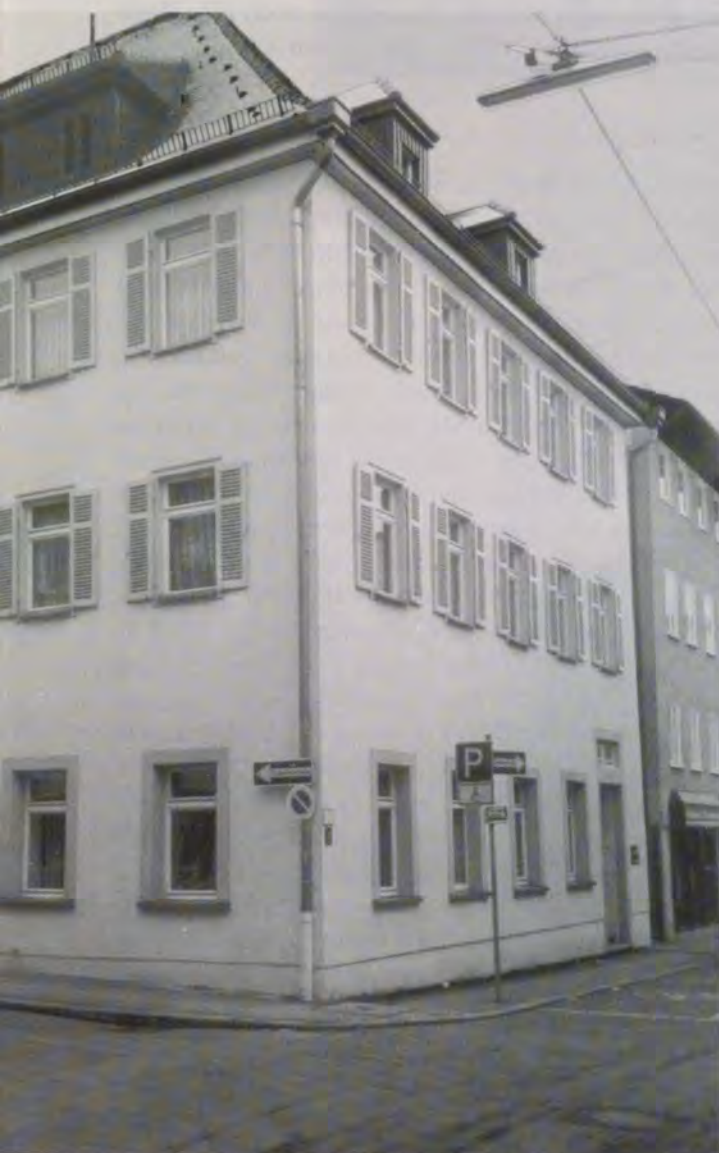
Alte evangelische Knabenschule in Göppingen, Kirchstraße 13.
