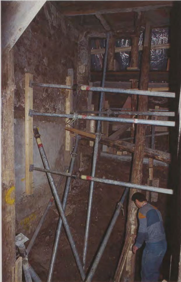
Unterfangungsarbeiten im Gebäude Richtstraße 3 im Bereich der künftigen Bibliothek.
