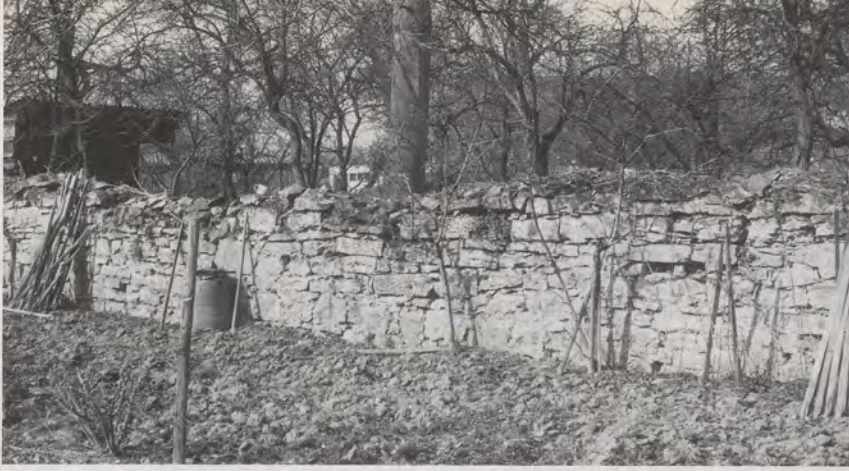
Zustand vor der Renovierung
