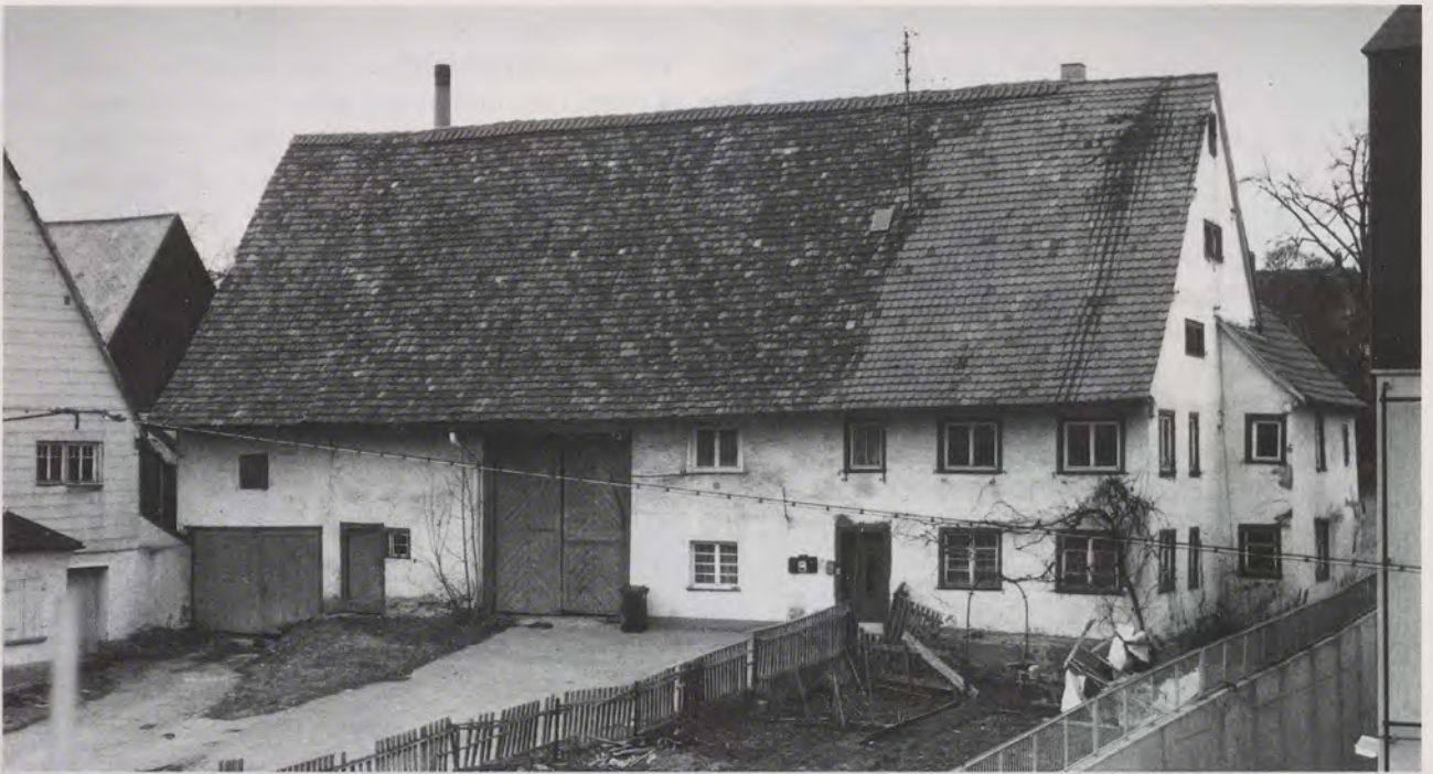
's Schützebuuren: Ein großes Haus, das früher zwei Ställe hatte. Hier ist der liegende Dachstuhl vollständig verblattet und am besten erhalten.
