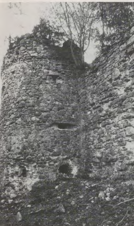
Heutiger Zustand der Burg Ratzenried: Links oben Turm (Grundriß Nr. 22) mit der Ringmauer der Hauptburg; die Schießscharten sind ausgebrochen. Der Turm in der Mitte oben (Nr. 21) ist am baufälligsten; bis zur Hälfte der Mauerdicke sind bereits die Steine herausgebrochen. Hier beginnt die geplante Sanierung. Oben rechts: Turm Nr. 22 von Süden her; Tannen wachsen auf dem Mauerkranz. Das Bild unten verdeutlicht, wie sehr Wald, Gebüsch und Gestrüpp die Mauerreste überwuchern.
