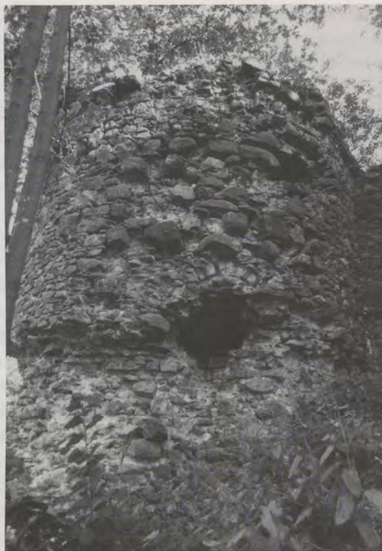
Heutiger Zustand der Burg Ratzenried: Links oben Turm (Grundriß Nr. 22) mit der Ringmauer der Hauptburg; die Schießscharten sind ausgebrochen. Der Turm in der Mitte oben (Nr. 21) ist am baufälligsten; bis zur Hälfte der Mauerdicke sind bereits die Steine herausgebrochen. Hier beginnt die geplante Sanierung. Oben rechts: Turm Nr. 22 von Süden her; Tannen wachsen auf dem Mauerkranz. Das Bild unten verdeutlicht, wie sehr Wald, Gebüsch und Gestrüpp die Mauerreste überwuchern.
