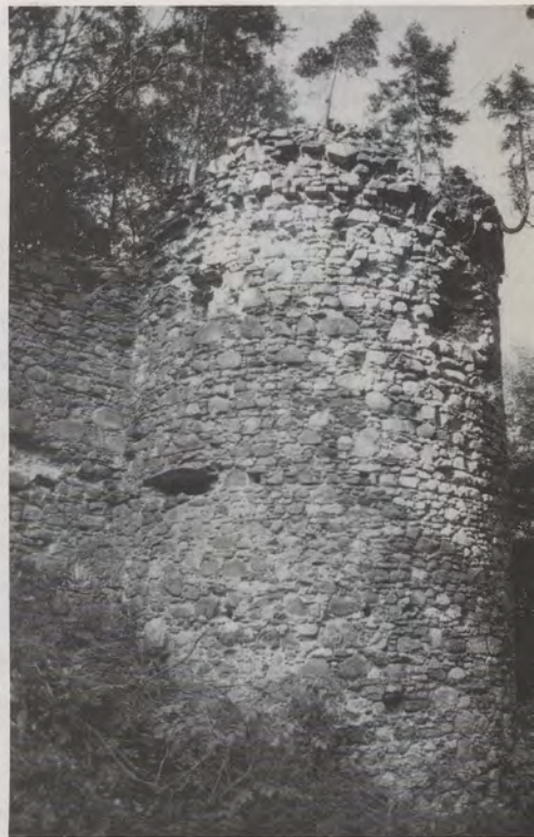
Heutiger Zustand der Burg Ratzenried: Links oben Turm (Grundriß Nr. 22) mit der Ringmauer der Hauptburg; die Schießscharten sind ausgebrochen. Der Turm in der Mitte oben (Nr. 21) ist am baufälligsten; bis zur Hälfte der Mauerdicke sind bereits die Steine herausgebrochen. Hier beginnt die geplante Sanierung. Oben rechts: Turm Nr. 22 von Süden her; Tannen wachsen auf dem Mauerkranz. Das Bild unten verdeutlicht, wie sehr Wald, Gebüsch und Gestrüpp die Mauerreste überwuchern.
