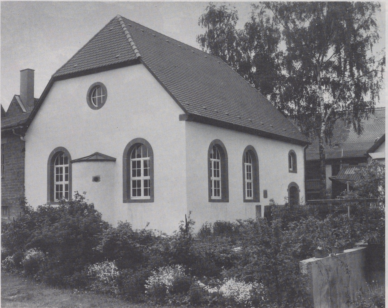
Die Ost- und Nordseite der Synagoge in Michelbach a. d. L. nach der Restaurierung.
