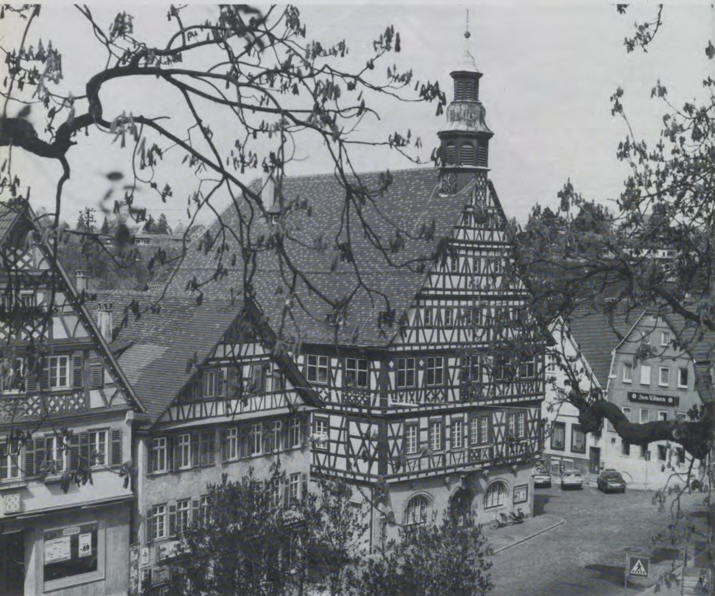
Das Rathaus in Backnang als Beispiel für das «fränkische» Fachwerk; erbaut nach dem Brand von 1693.
