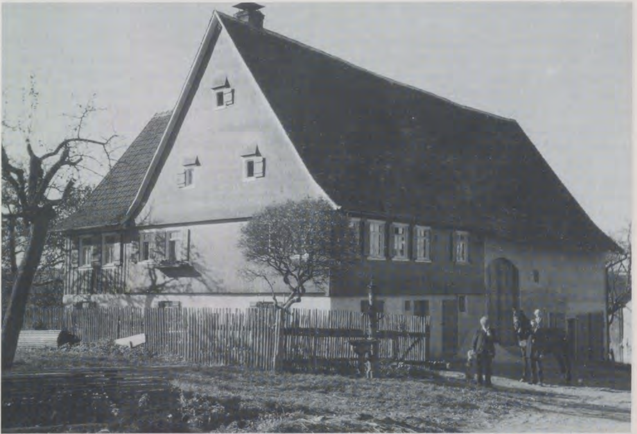
Das Elternhaus des Autors im Jahre 1928. Ein Steinhauer hat es außerhalb des Ortskerns als Handwerkerhaus erbaut. Ursprünglich hörte das Gebäude mit der Scheuer auf. Die Großeltern kauften das Haus im Jahre 1862 und erweiterten es um zwei «Fächer». Der seitliche Anbau entstand erst 1919.
