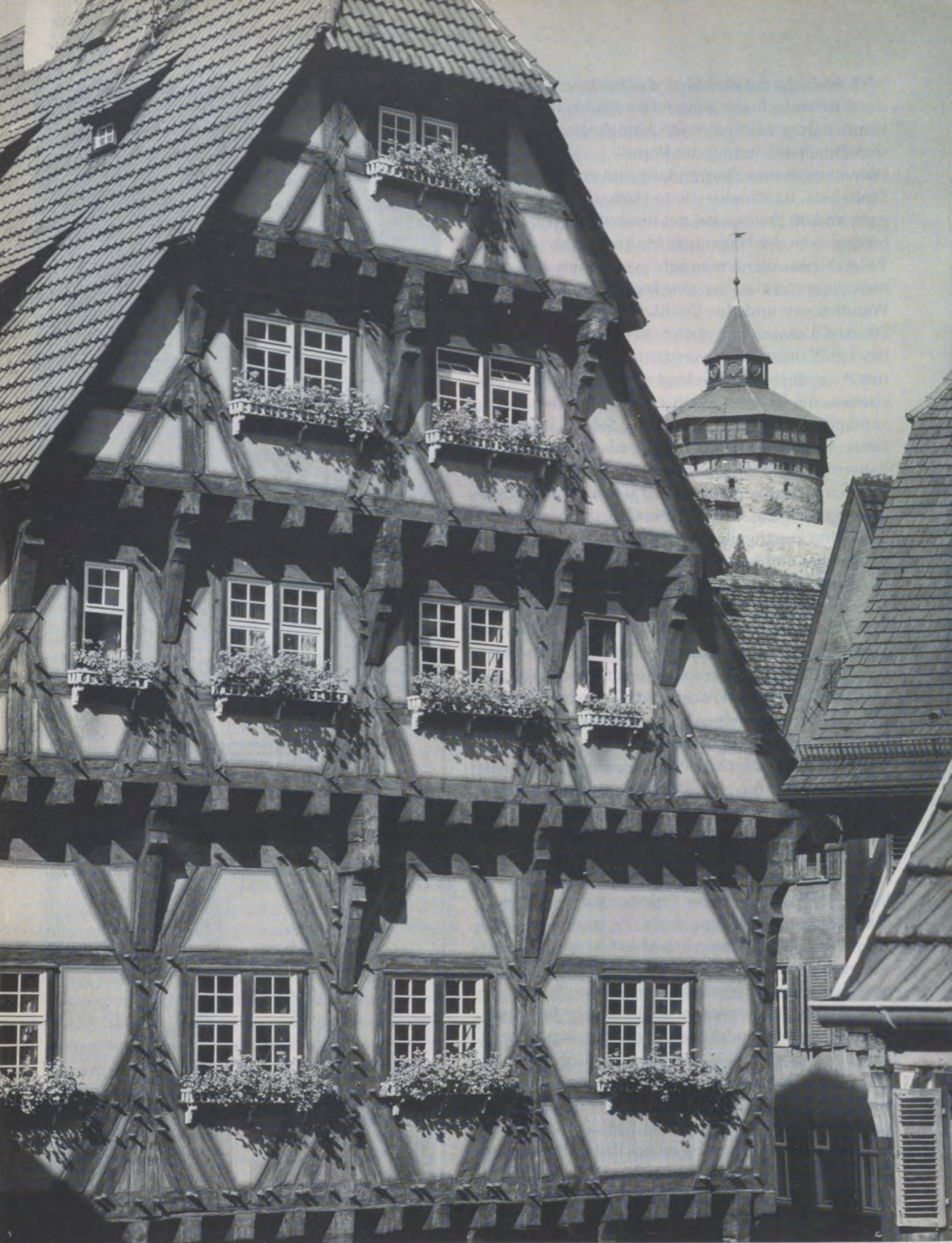
Altes Rathaus in Esslingen als Beispiel für «alemannisches» Fachwerk. Im Hintergrund der Dicke Turm der Esslinger Burg, ein Teil der Stadtbefestigung.
