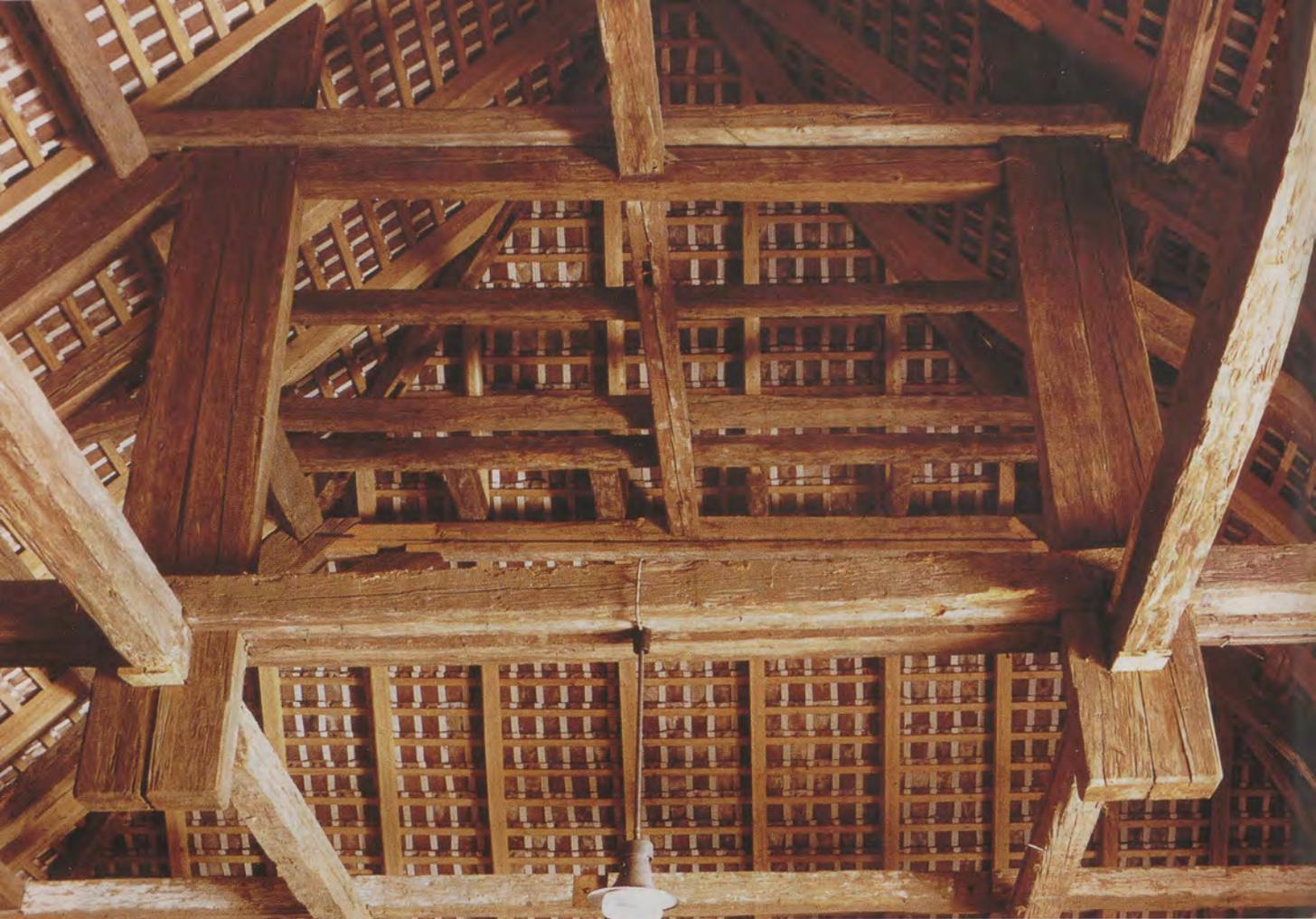
*Blick in die Dachkonstruktion – doppeltes Hängewerk – der Kelter in Pfedelbach-Heuholz im Hohenlohekreis.*
