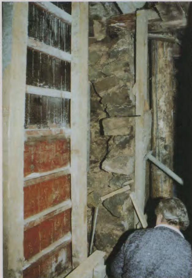
Die Keller-Außenwand nach Westen mußte erneuert werden. Links die Verschalung der neuen Betonwand, rechts die «bauchige» alte Kellerwand. Eine Vormauerung wird den Beton verdecken.
